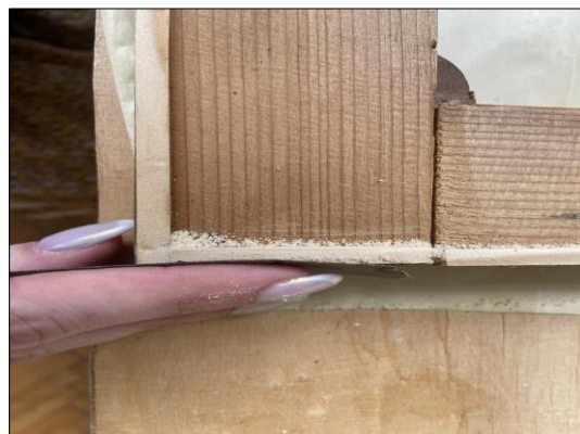
Slika 75. Adaptacija podokvira, obrada bridova drvenih letvica brusnim papirom, snimila Iva Galijan, 2023.
