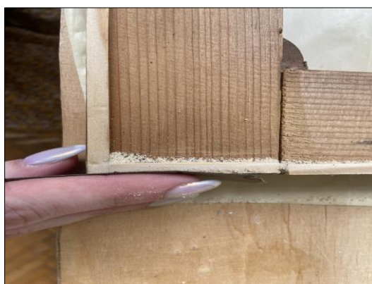
Slika 75. Adaptacija podokvira, obrada bridova drvenih letvica brusnim papirom, snimila Iva Galijan, 2023.
