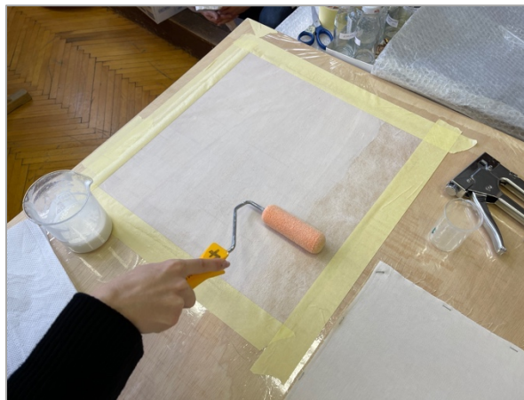
Slika 120. Nanošenje mješavine ljepila Disperzije K 360 i Plextola D 512 pomoću valjka, 2023.
