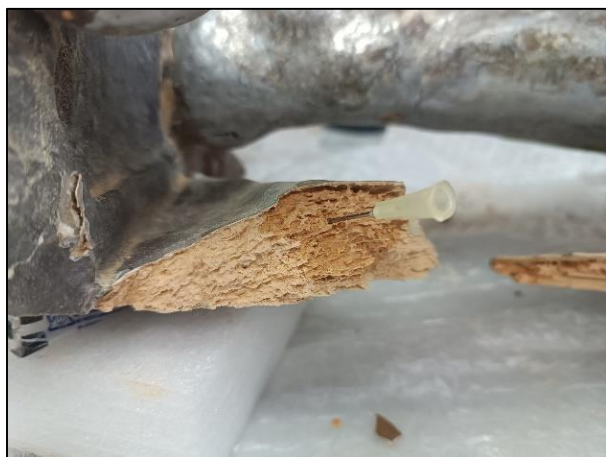
Slika 87. Konsolidiranje nestabilnog i oštećenog dijela unutarnjeg plašta, fotografirala: S. Knežević, veljača 2024.
