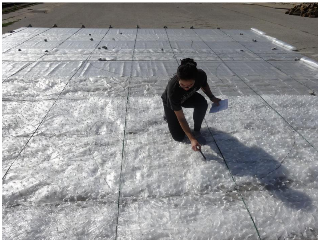
Fotografija 16: Precrtavanje sheme na stvarnu dimenziju plahti 1
