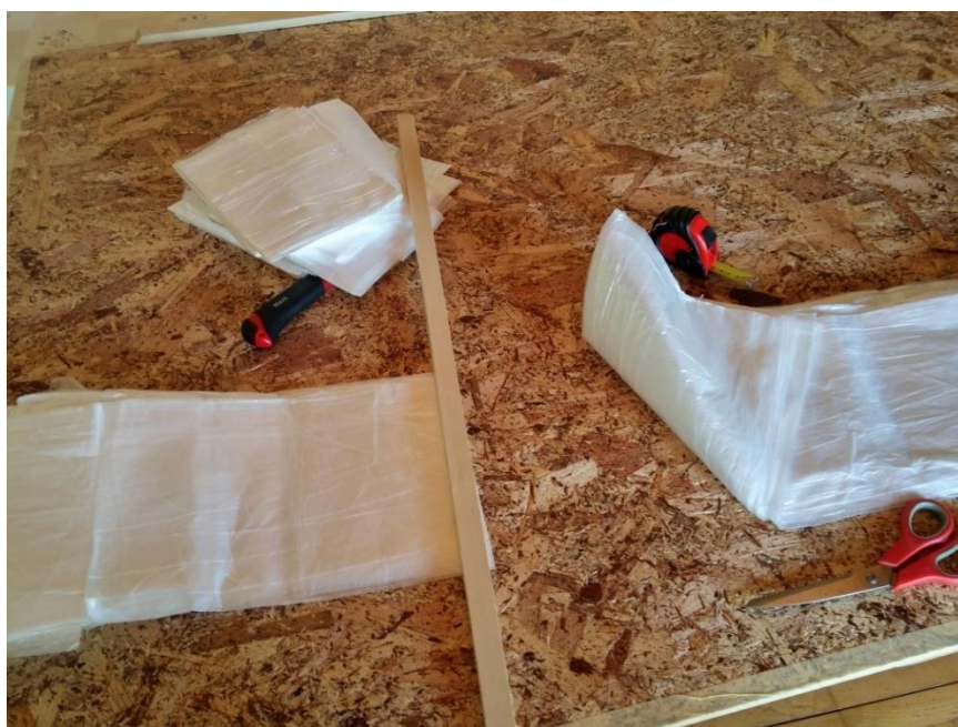
Fotografija 15: Rezanje najlona na određenu duljinu
