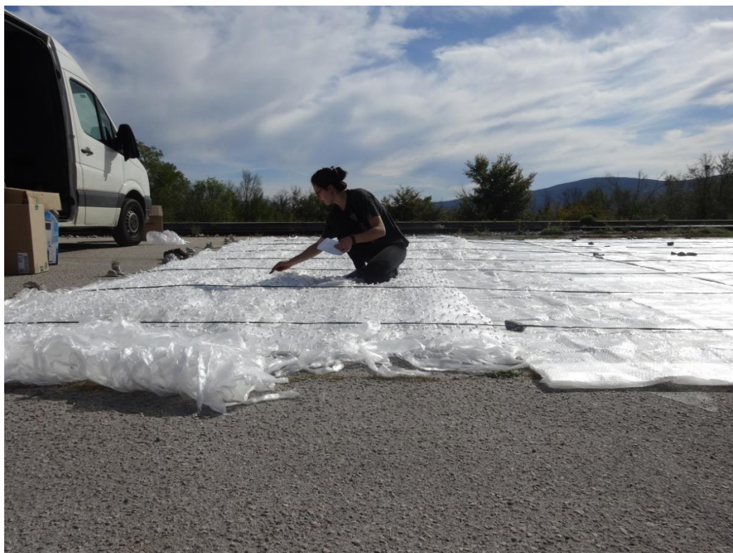
Fotografija 17: Precrtavanje sheme na stvarnu dimenziju plahti 2
