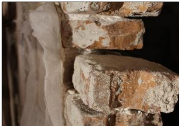
Slika 64. Detalj, opečni zid
