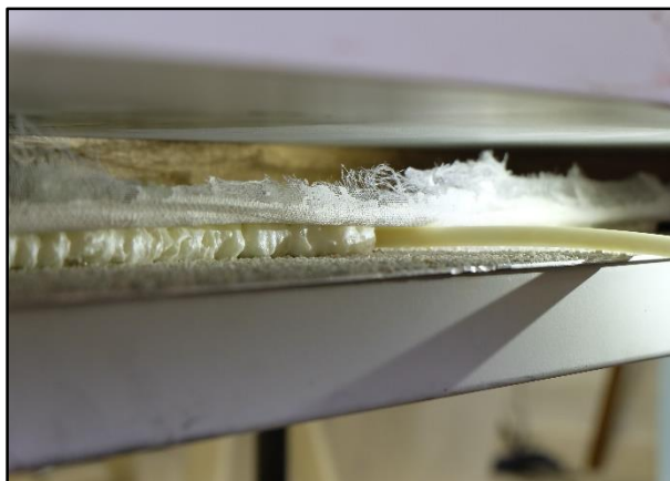
Slika 133. Dodatno injektiranje PUR pjene
