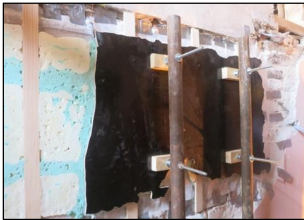
Slika 89. Čvrsti nosilac na licu slike sastoji se od drvenih letvica vezanih PUR pjenom i panel ploče koja je izrezana tako da prati oblik fragmenta i cijela se konstrukcija učvrstila za skelu vijcima
