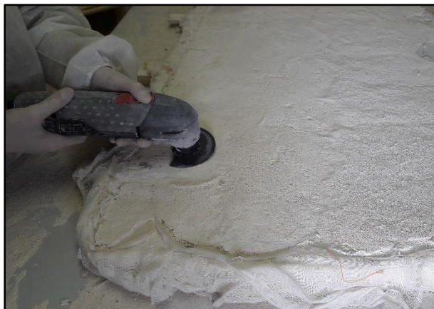
Slika 100. Stanjivanje poledine fragmenta
