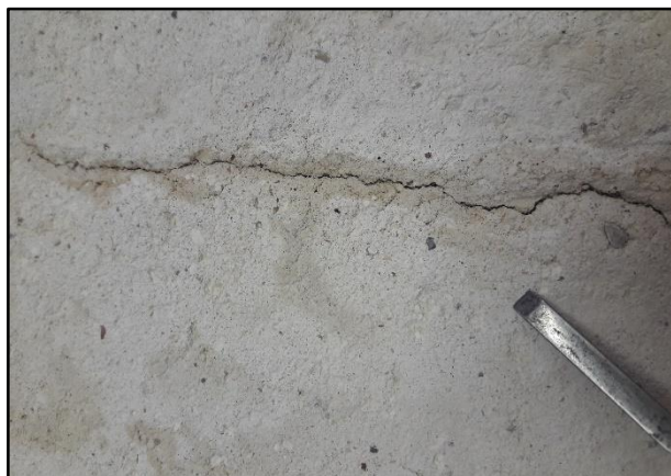
Slika 102. Proširivanje pukotina
