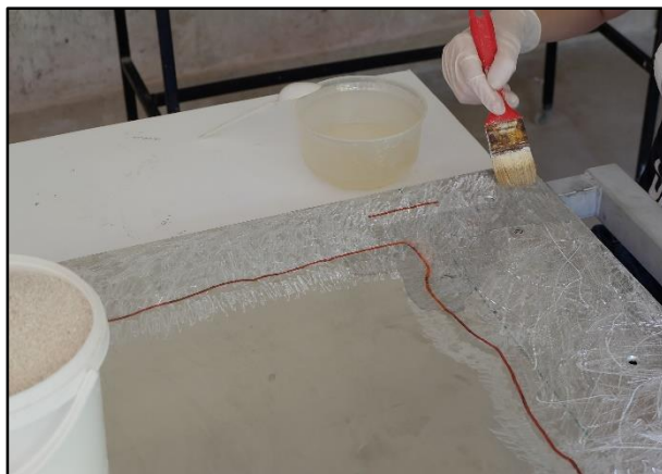
Slika 130. Nanošenje epoksi-smole
