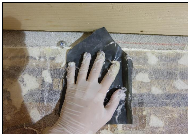
Slika 142. Skidanje facinga acetonom natopljenom vatom prekrivenom nepropusnom folijom
