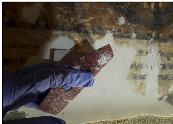
Slika 156. Obrada (teksturiranje) površine nadomjesne žbuke intonaca
