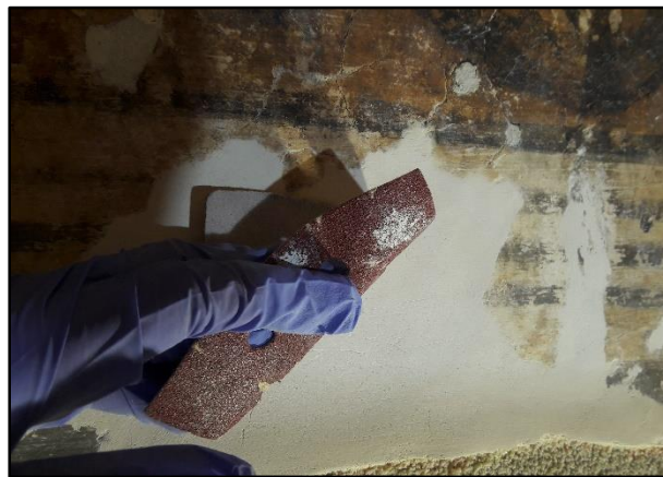
Slika 156. Obrada (teksturiranje) površine nadomjesne žbuke intonaca
