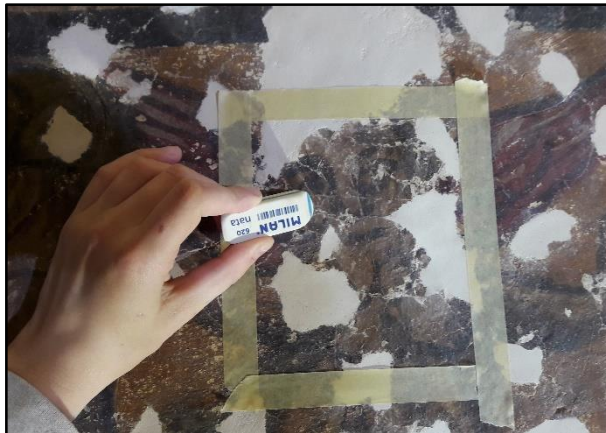
Slika 157. Čišćenje lica zidnog oslika gumicom za brisanje
