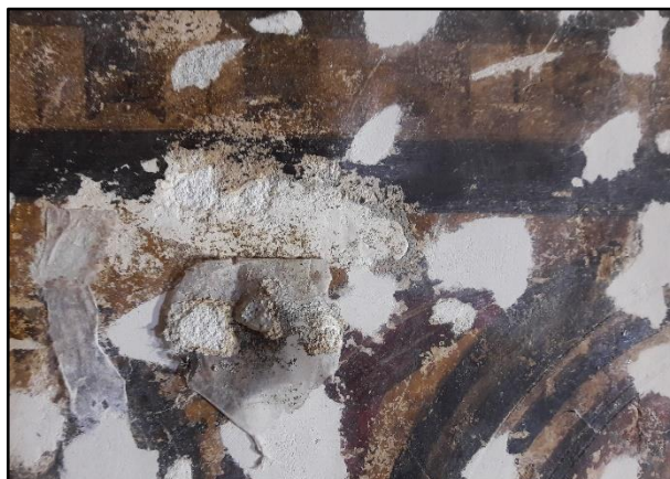
Slika 145. Oštećenje slikanog sloja tijekom skidanja facinga
