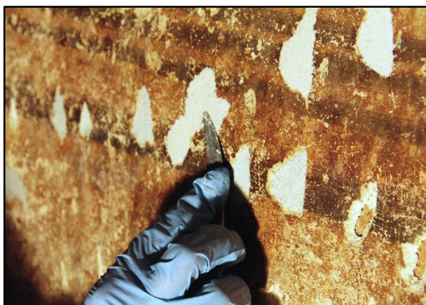
Slika 85. Žbukanje oštećenja
