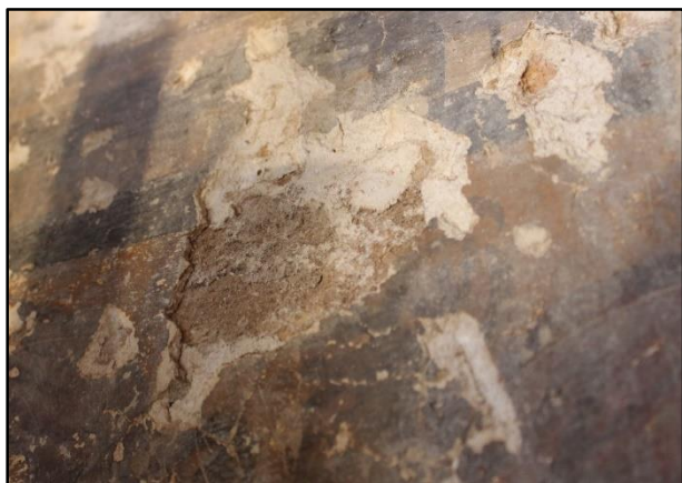
Slika 66. Detalj, sloj intonaca na zidu od opeke
