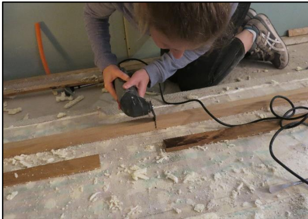
Slika 137. Skidanje pomoćnih letvica s lica oslika
