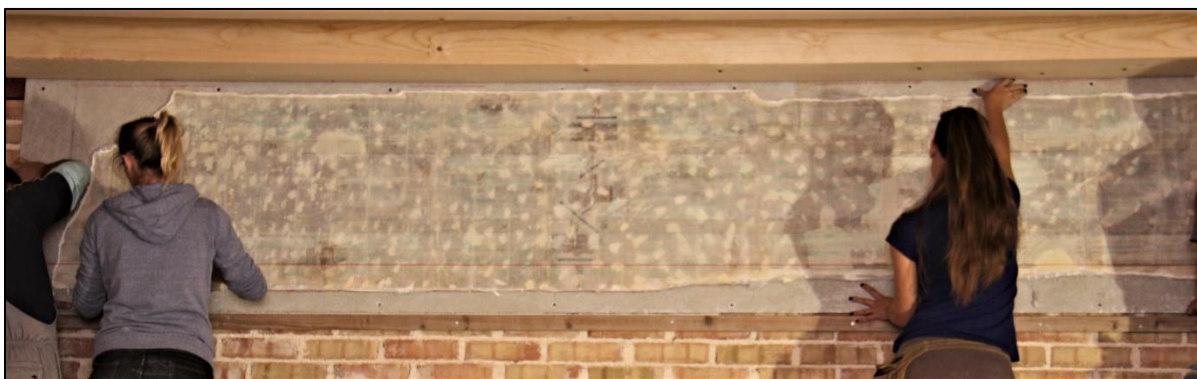
Slika 173. Privremeno postavljanje fragmenta s pokretnim na nepokretni nosač te provjera njegovog smještaja napinjanjem konopca do sačuvanog oslika vijenca na sjevernom dijelu zapadnog zida u središnjem salonu.
