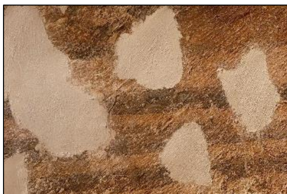
Slika 184. Teksturirana površina novih žbukanih nadoknada.
