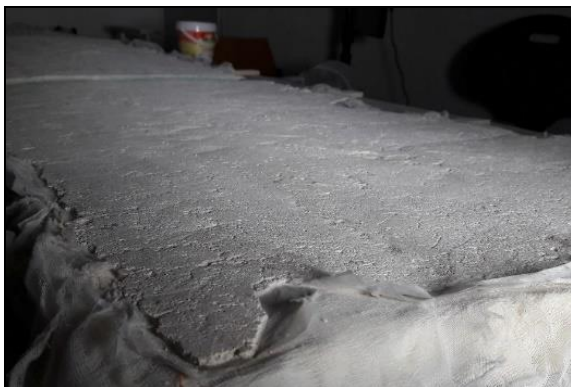
Slika 133. Izgled površine intonaca nakon brušenja i stanjivanja.
