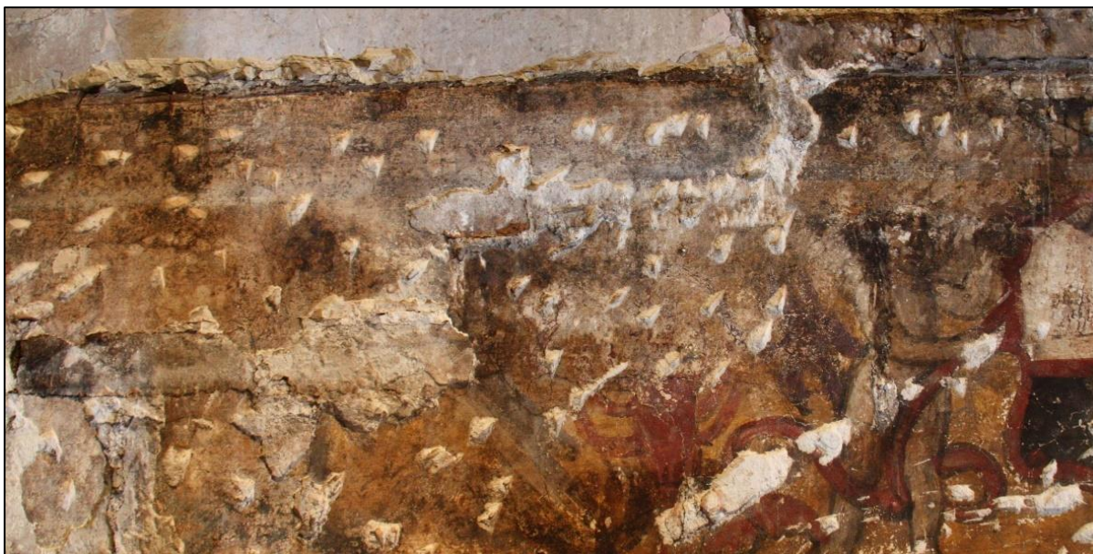
Slika 110. Značajni gubici slikanog sloja i intonaca na mjestu gdje se nekada nalazilo stubište. Čitavom površinom slike vidljive su lakune nastale udaranjem čekića (natučenja).
