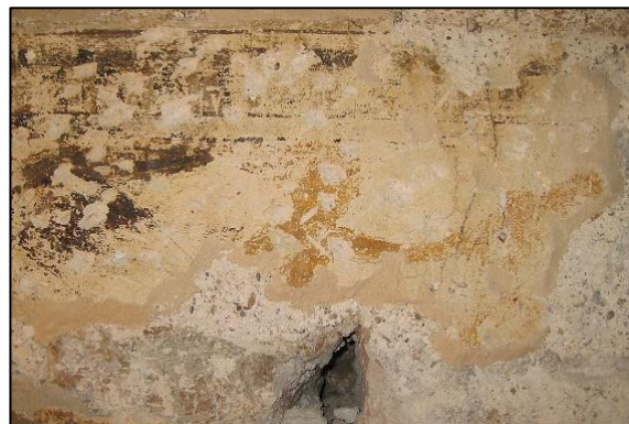
Slika 82. Detalj „opšava“ od nadoknadne žbuke, nanesenih oko očuvanih fragmenata zidnog oslika vijenca na jugoistočnom zidu središnjeg salona.
