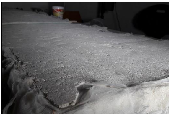
Slika 133. Izgled površine intonaca nakon brušenja i stanjivanja.
