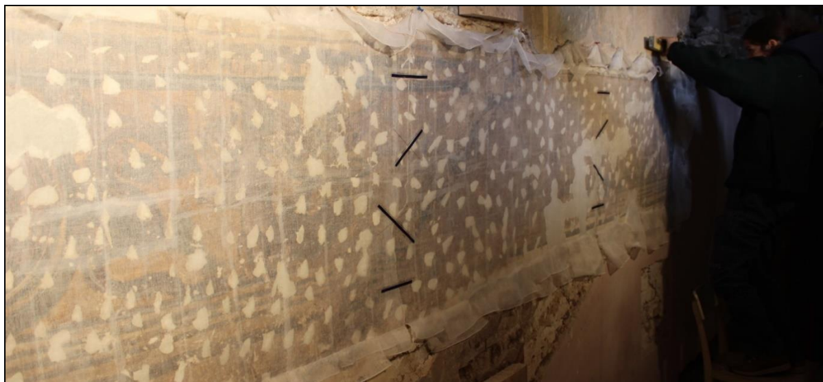
Slika 121. Fragment nakon polaganja facinga , podijeljen (rezanjem) na tri manja dijela. Preko rezova su ucrtani križići i zalijepljene trakice tkanine. Oni služe točnom spajanju triju dijelova fragmenta u budućnosti.
