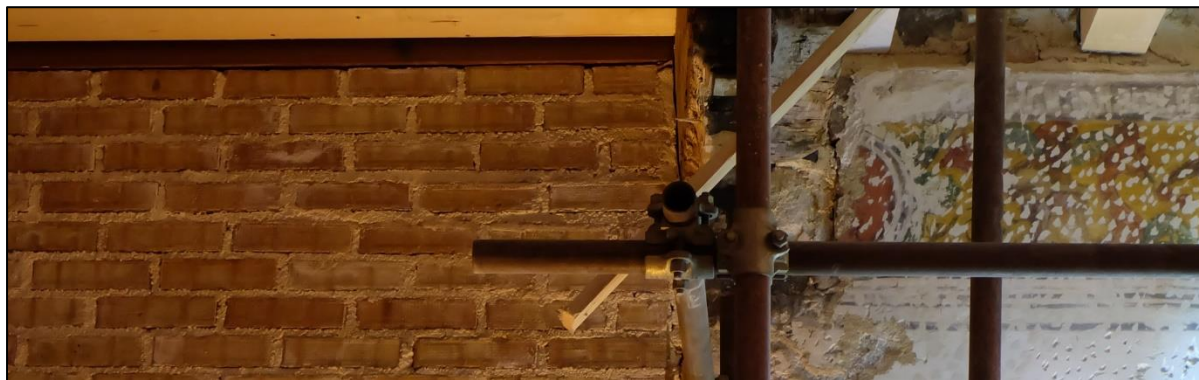
Slika 157. S desne strane fotografije nalazi se oslik vijenca na sjevernom dijelu zida od kojeg je napet konopac do pokretnog nosača na južnom dijelu zida kako bi se ucrtao ispravan položaj odvojenog fragmenta u odnosu na ostatak oslika vijenca.
