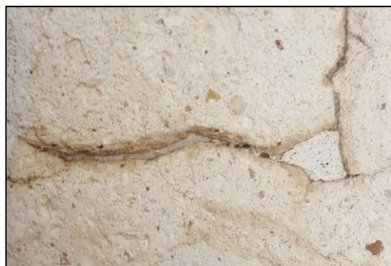
Slika 134. Jedna od pukotina u sloju intonaa koja seže sve do vidljive poleđine facinga .
