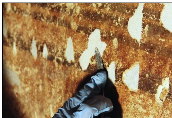
Slika 119. Zapunjavanje oštećenja u žbukom sloju (lakuna i pukotina) vapnenom žbukom, prije nanošenja facinga .
