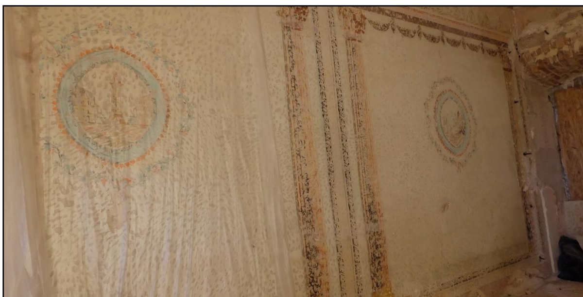
Slika 77. Zapadni zid sjeveroistočne prostorije na prvom katu kuće Moise, ukrašen zidnim slikama iz 19. stoljeća.
