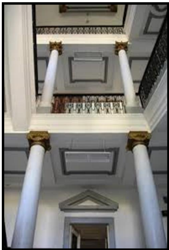
Slika 18 Palača Šećerane, monumentalno glavno stubište
