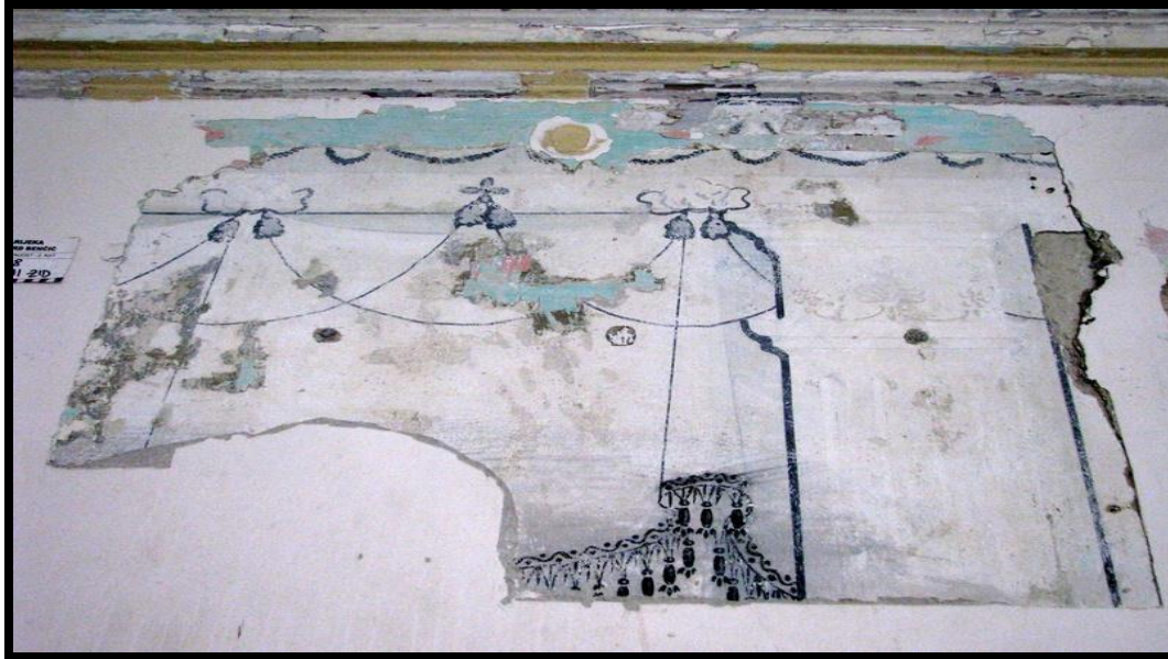
Slika 52 Drugi kat, prostorija 208, sjeverni zid, stanje prije početka radova 2006.
