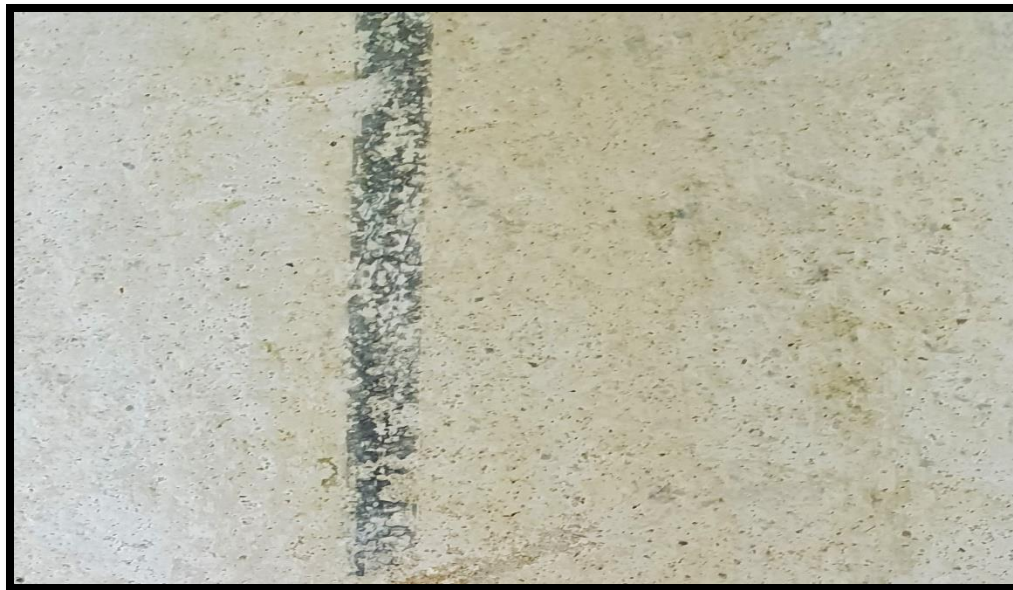
Slika 72 Žučkaste mrlje nastale kao posljedica otpuštanja veziva iz naknadnog naliča
