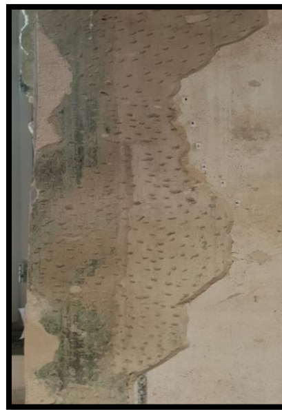
Slika 85 Prostorija 208, sjeverni zid, detalj ispiketane mramorizacije
