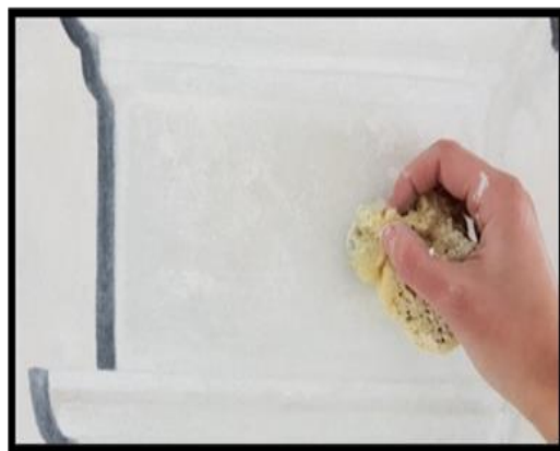
Slika 96 Detalj, imitacija teksture površine
