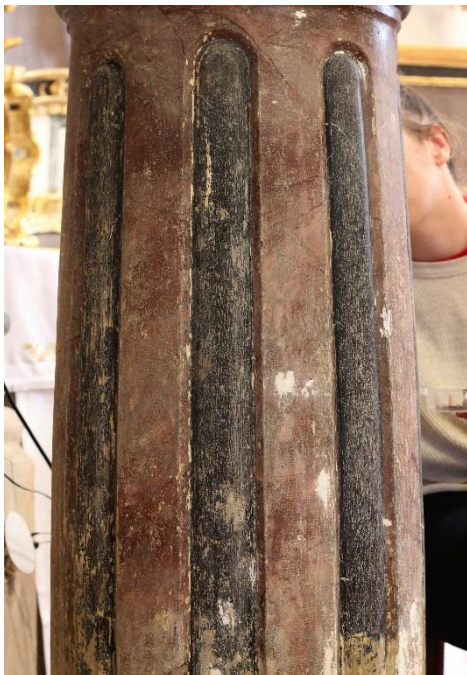
Sl. 123 – Stup prije reintegracije u slikanom sloju
