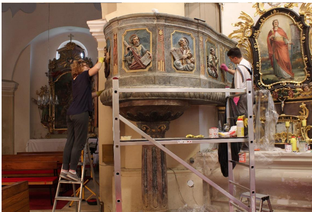
Sl. 105 - U fazi uklanjanja preslika
