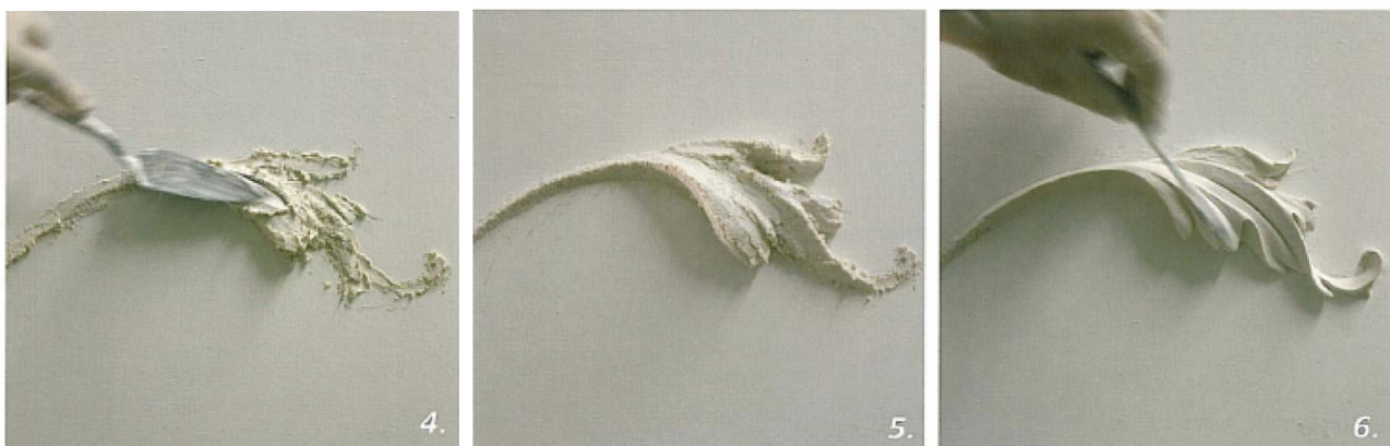
Sl. 131 - Faze in situ modeliranja štuka
