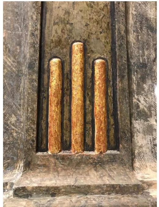
Sl. 122 - Dno pilastra, nakon reintegracije u sioju polikromije i pozlate
