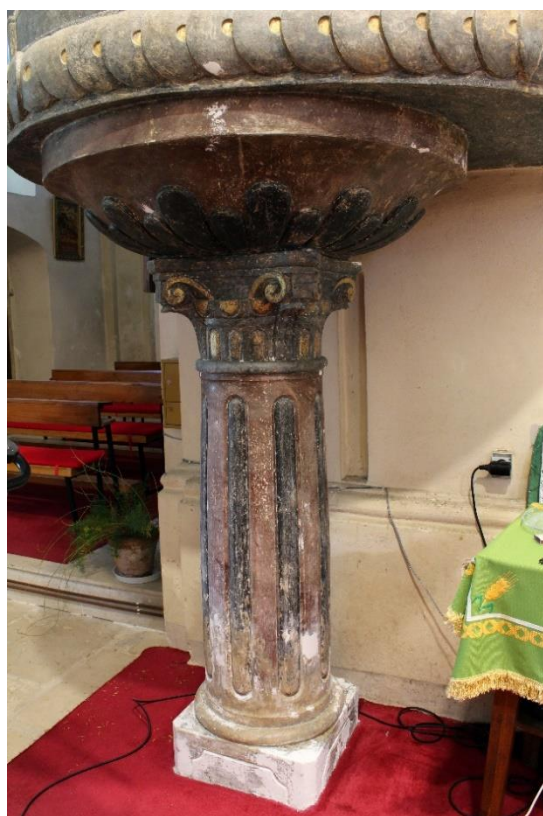
Sl. 109 – Stup nakon uklanjanja preslika
