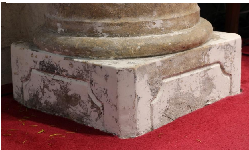
Sl. 116 – Stup nakon izvedenih nadoknada u sloju nosioca
