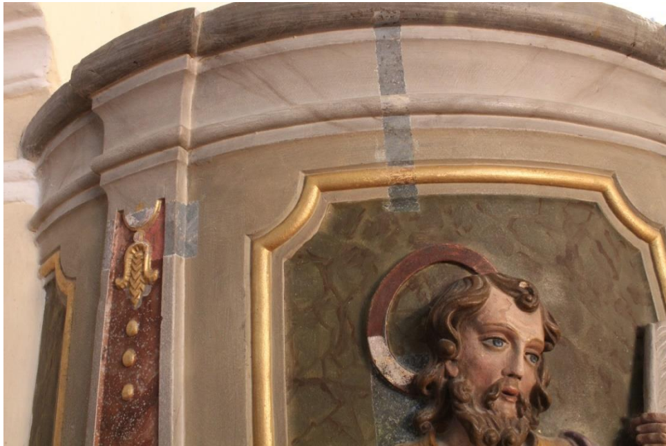
Sl. 42 - Primjeri izrađenih sondi
