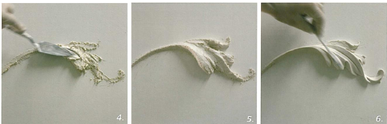
Sl. 131 - Faze in situ modeliranja štuka
