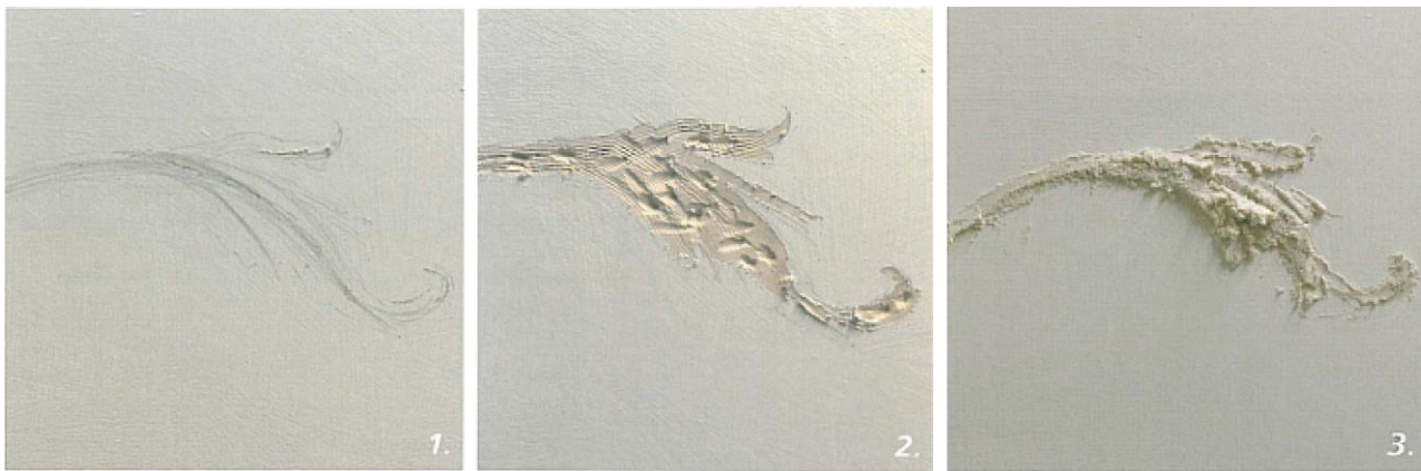
Sl. 130 - Početne faze in situ modeliranja: bilježenje crteža, ogrublјivanje površine i postavljanje grube žbuke
