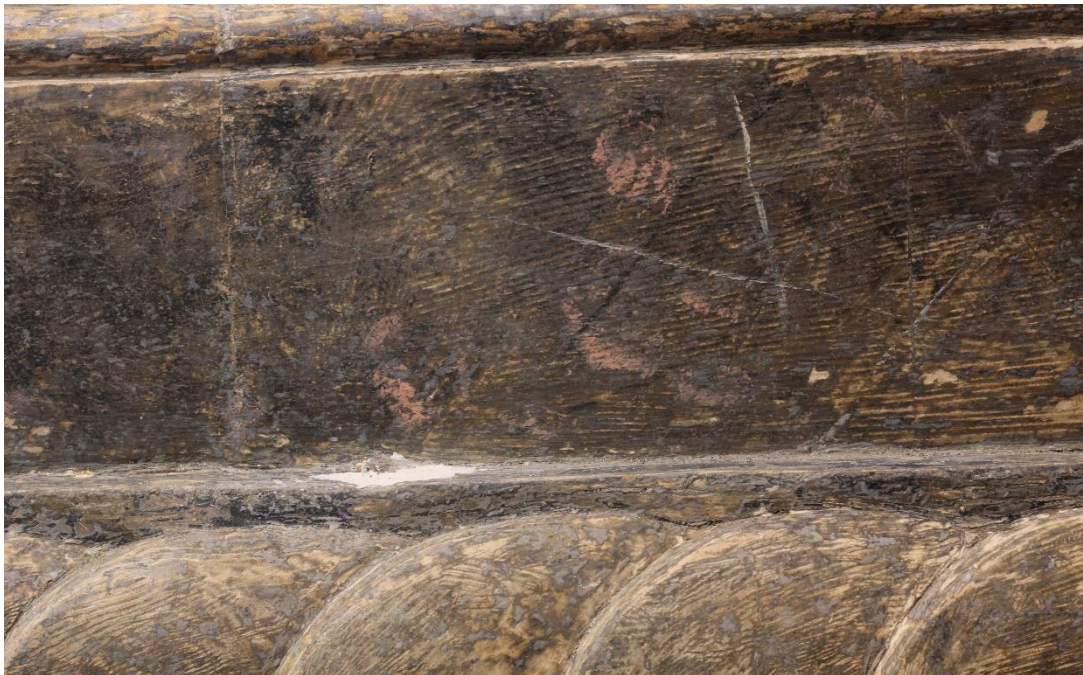
Sl. 43 - Ogrubljena površina nosioca
