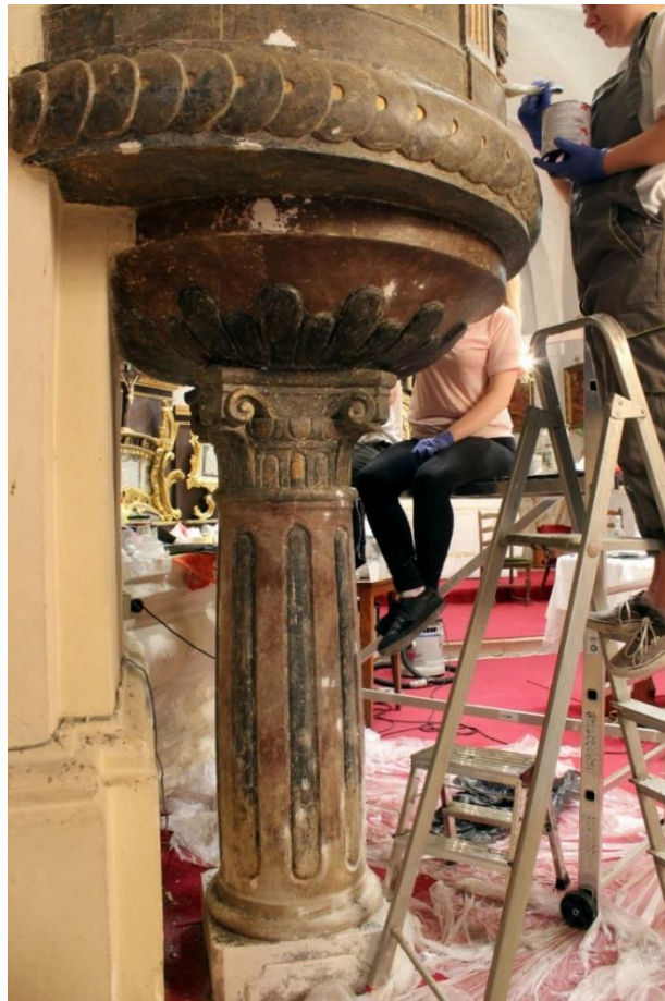
Sl. 117 – Podnožje govornice i stup nakon izvedenih nadoknada u sloju nosioca
