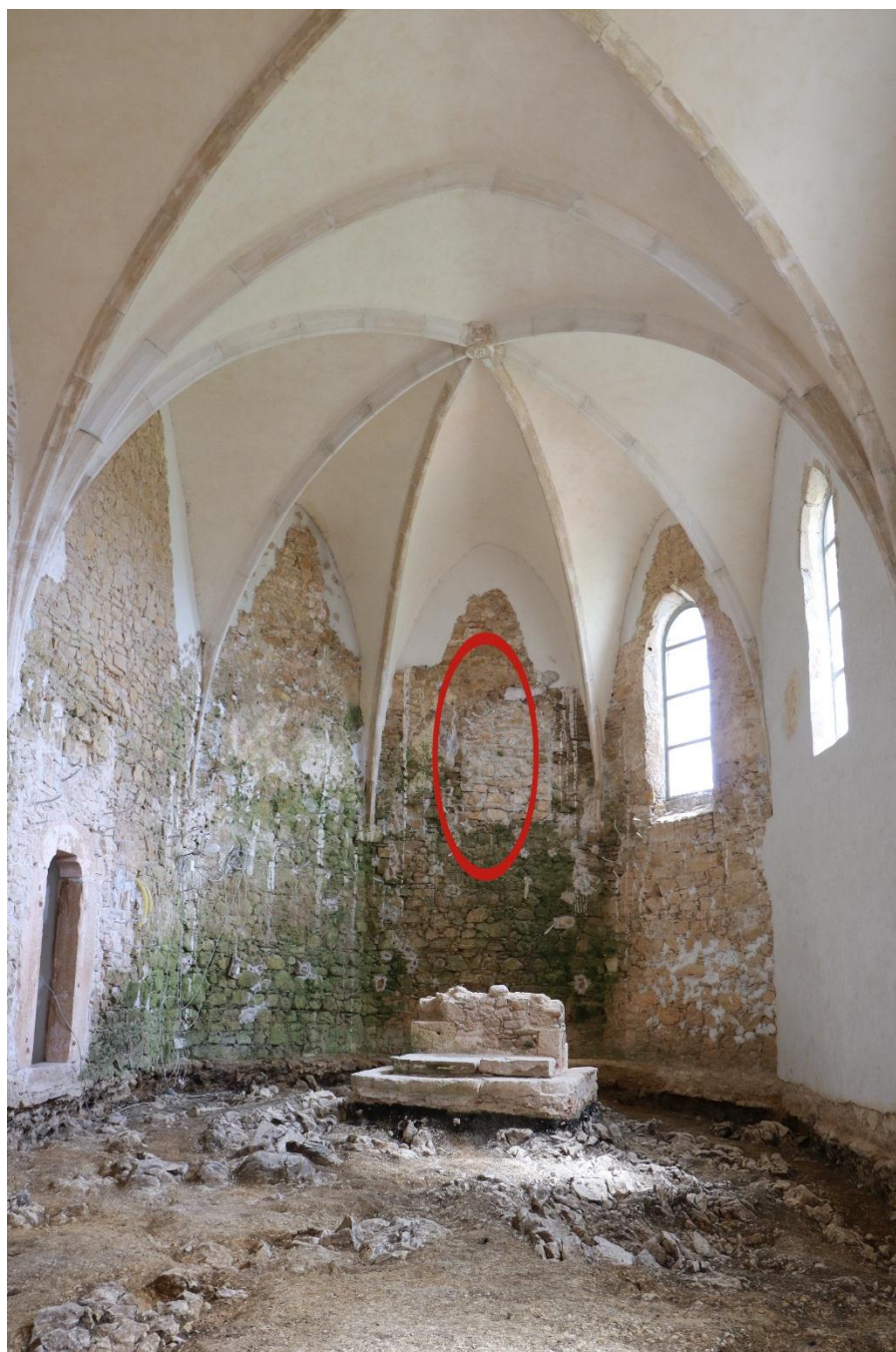
Slika 32: Svetište s vraćenim svodnim rebrima i oznaka (crvena elipsa) pozicije na koju bi kopija bila postavljena
