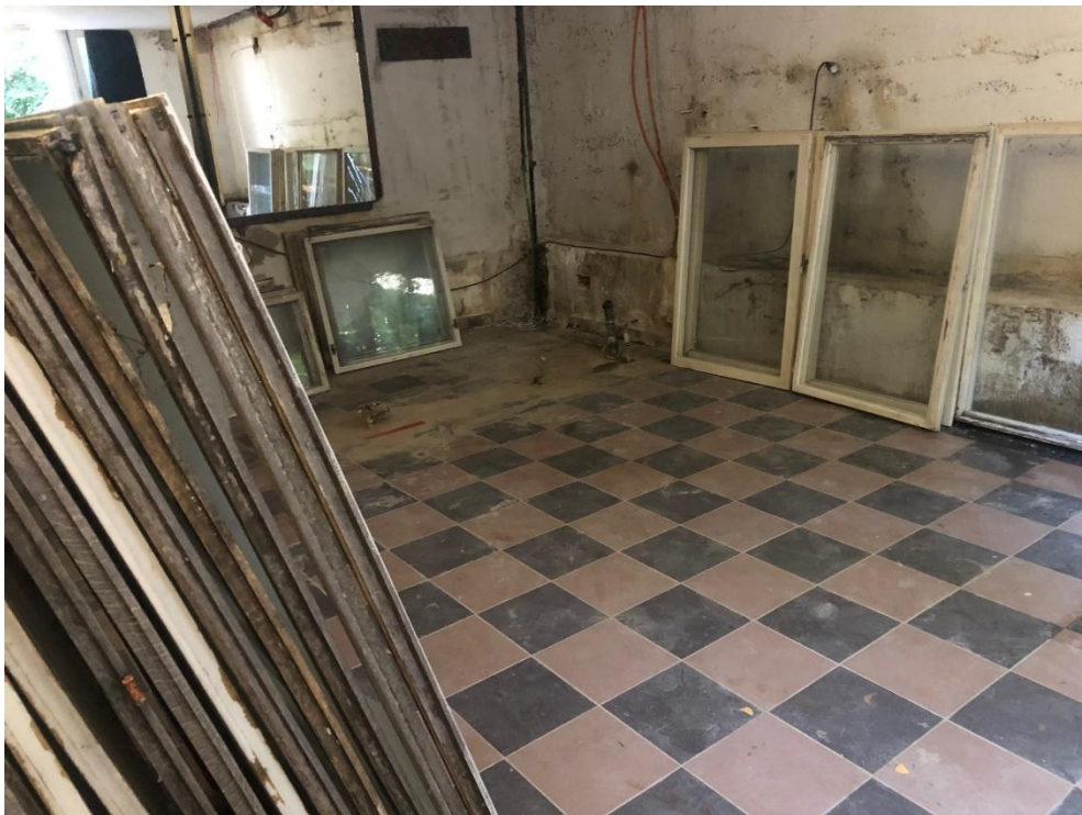
Slika 40 Postavljenje prostorne instalacije
