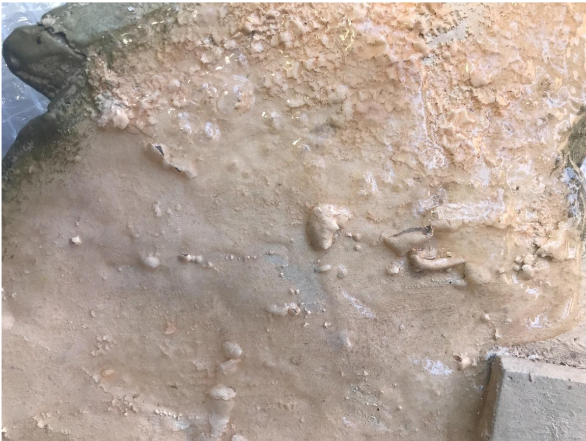
Slika 110. Uklanjanje kita kemijskim načinom pomoću Paint&Varnish gela, poledina lijevog krila, u tijeku radova, detalj, fotografirala Hana Knežević, 2020.
