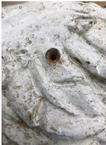
Slika 125. Oštećenje uzrokovano metalnim vijkom, prednja strana desnog krila, u tijeku radova, detalj fotografirala Hana Knežević, 2019.
