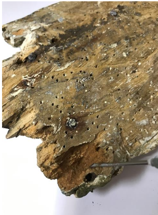
Slika 101. Desno krilo tijekom konsolidiranja drvenog nosioca, u tijeku radova, detalj, fotografirala Hana Knežević 2020.
