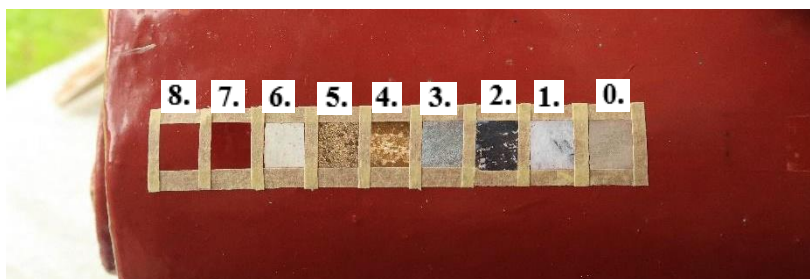
Slika 70. Sonda br. 5., Stratigrafski slojevi na gornjoj strani volute, fotografirala Hana Knežević, 2019.
