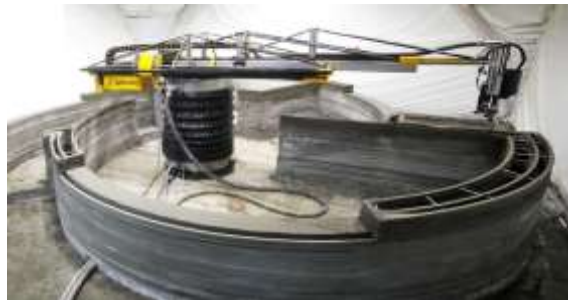
Slika 62: Proces izrade kuće izrađene 3D pisačem
