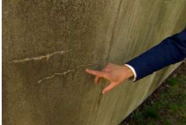
Slika 52: Primjer zacjeljivanja betona
