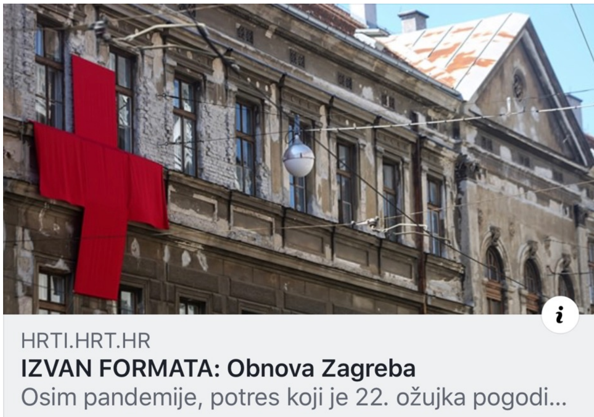
slike 35. ( Crveni križevi na oštećenim zgradama u potresu , u sklopu Projekt Ilica: Q'art), Obnova Zagreba, Izvan formata, HRT 3, Zagreb, 2020.
