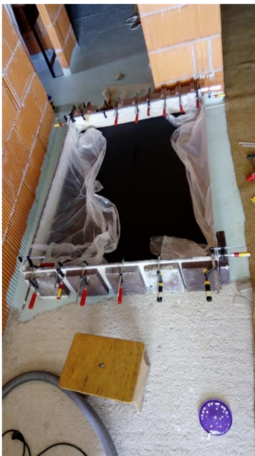
Sl. 21. Ljepljenje okvira od ljepenke
