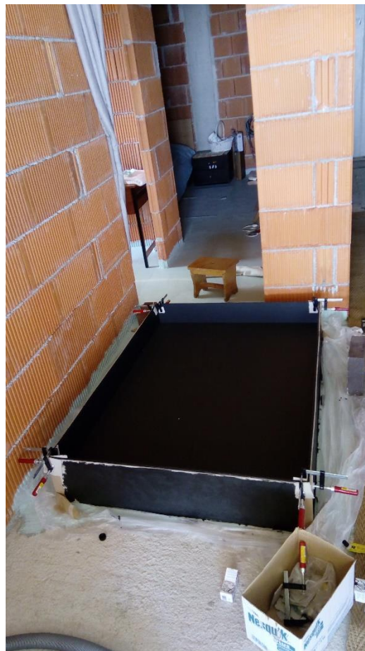
Sl. 22. Ljepljenje uglova okvira
