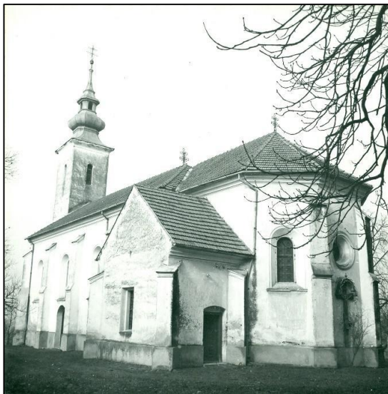
Slika 2. Župna crkva sv. Marije od Pohoda – vanjština: pogled na južno pročelje i svetište; snimio: N. Vranić, 1966. god.; inv. br. 32168; neg. II-7775
