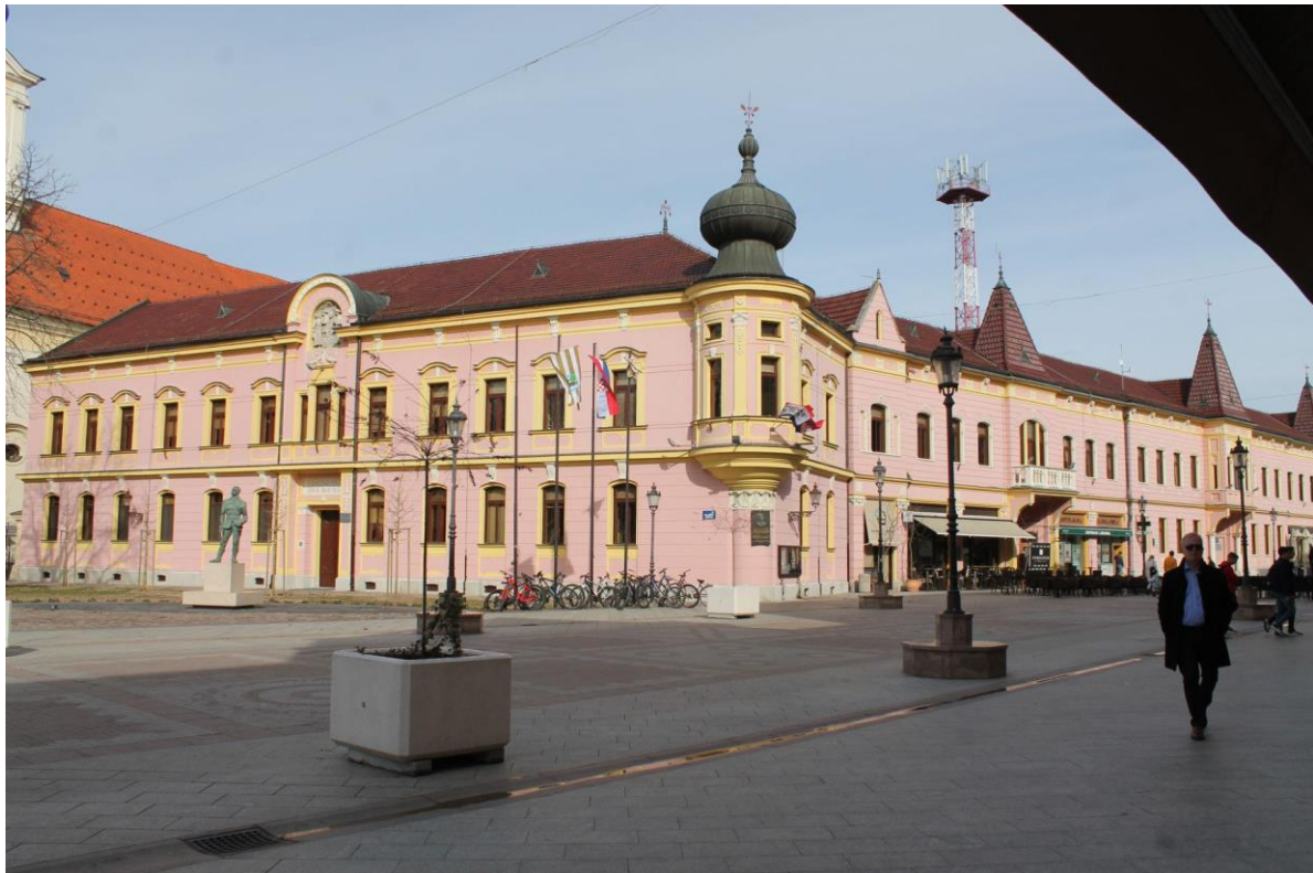
Sl. 15. Zgrada Brodske imovne općine, 1910. Vinkovci
