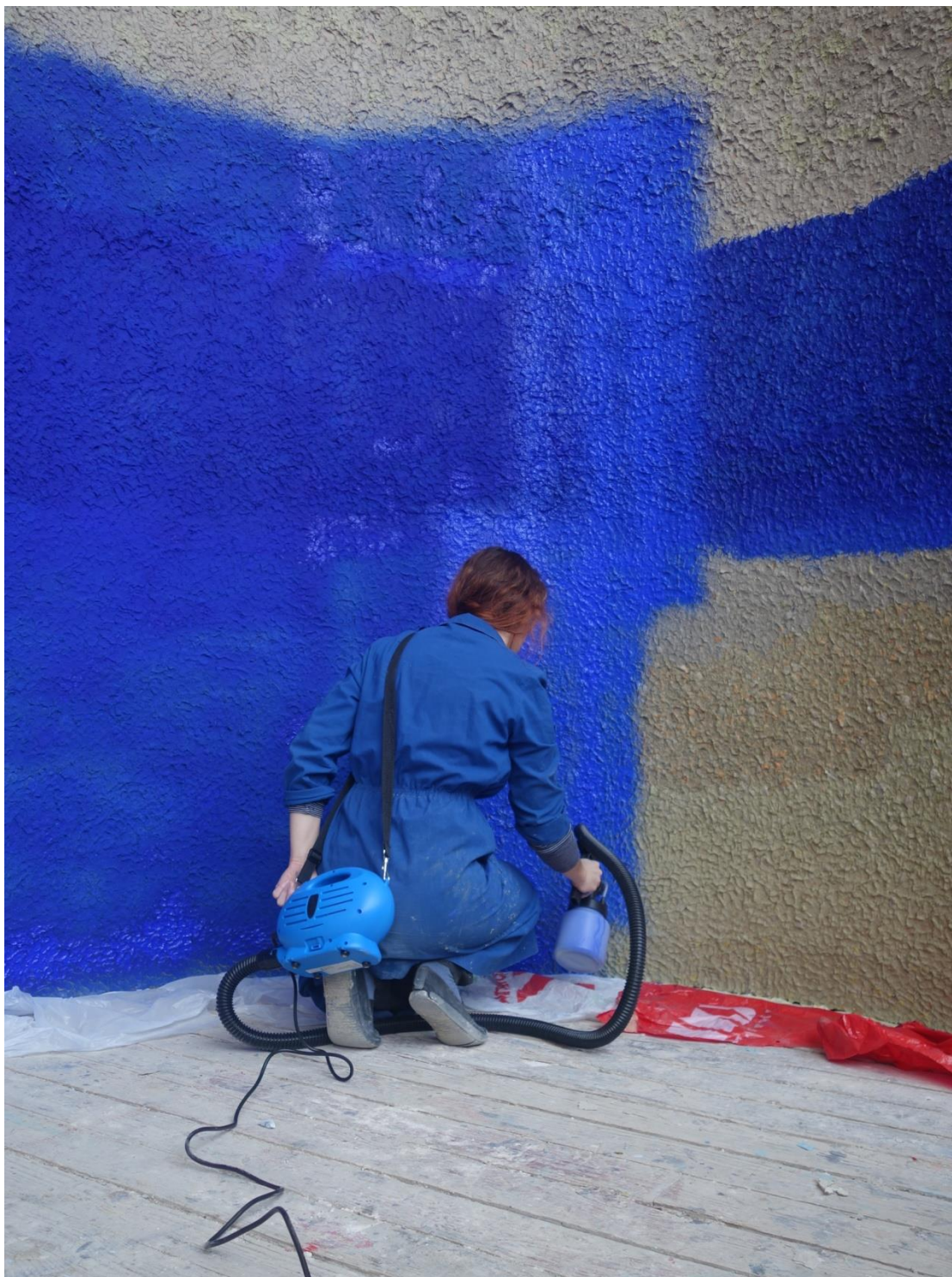
Slika 24: Bojenje rada električnim raspršivačem boje
