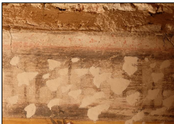
Slika 74. Detalj, ispucavanje konopca
