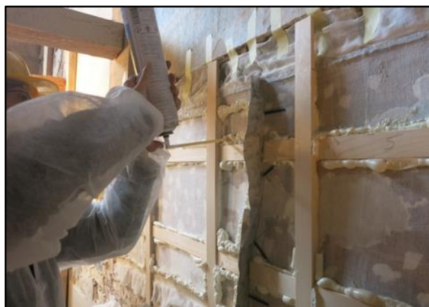
Slika 88. Postavljene aluminijske trake kako u njih ne bi prodrla PUR pjena te kako se PUR pjena ne bi na rezovima povezala
