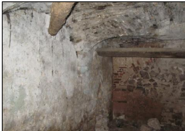
Slika 46. Detalj, jedrasti svod prizemlja
