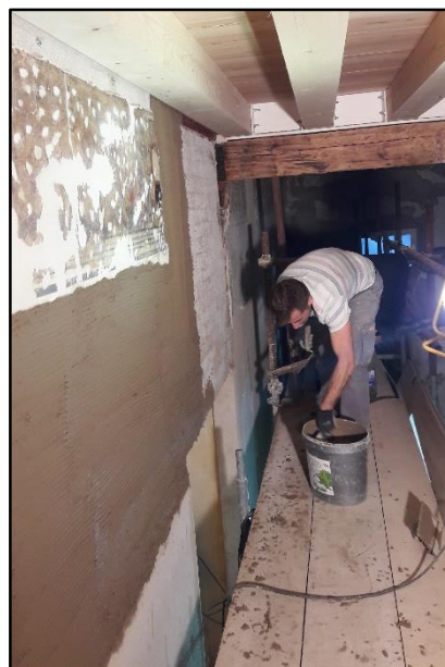
Slika 159. Nanošenje dugog sloja žbuke oko fragmenta
