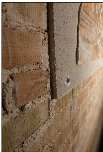
Slika 158. Žbuka s vlaknima nagurana u prostor ispod aluminijske ploče
