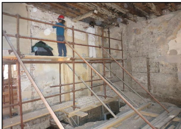
Slika 90. Razgradnja zida s poledine zida
