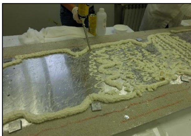
Slika 131. Postavljanje PUR pjene
