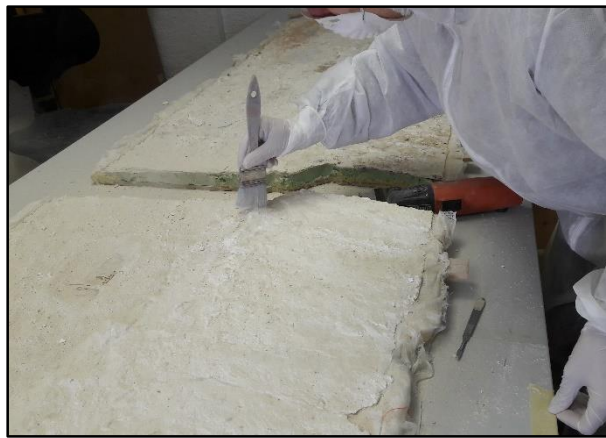
Slika 101. Otprašivanje površine pomoću širokog kista
