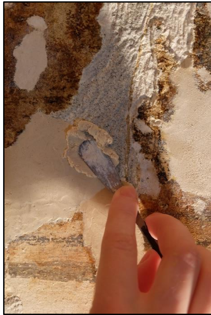
Slika 154. Detalj, postavljanje nadomjesne žbuke intonaca
