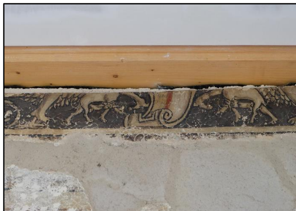
Slika 54. Detalj odrezanog vijenca
