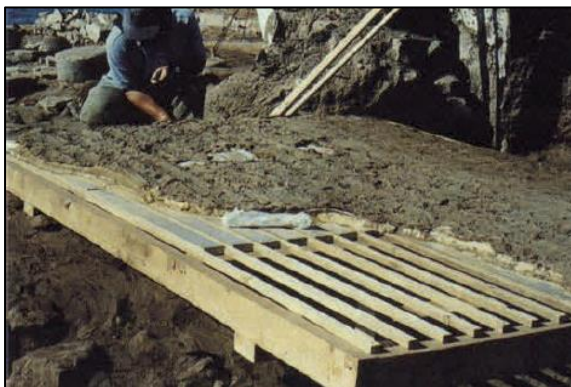
Slika 43. Odvojen fragment zidne slike položen na privremeni nosač.
