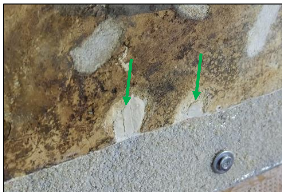
Slika 181. Zelenim strelicama označene su nadoknade izvedene žbukom s kalcitnim punilom koje nisu nanese u razini sa slikanim slojem te ih je bilo potrebno stanjiti i ponovno ispuniti.
