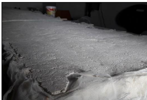
Slika 133. Izgled površine intonaca nakon brušenja i stanjivanja.
