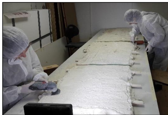
Slika 132. Stanjivanje i izravnavanje žbuke sljubnica i intonaca električnim brusilicama pod kosim svjetlom.
