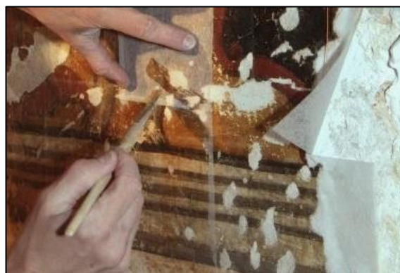
Slika 120. Nanošenje prvog sloja japanskog papira otopinom akrilne smole Paraloid B72 u acetonu.
