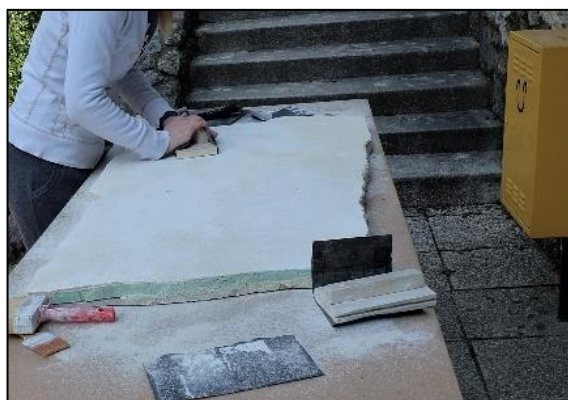
Slika 143. Brušenje trećeg sloja vapnenog kazeinata s punilom prije nanošenja nadolazećih slojeva backinga .
