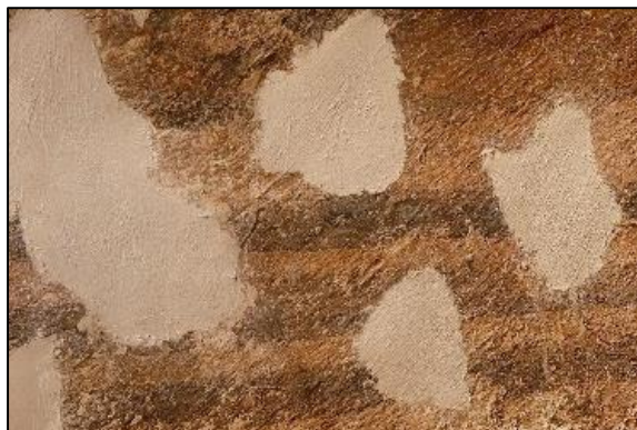
Slika 184. Teksturirana površina novih žbukanih nadoknada.
