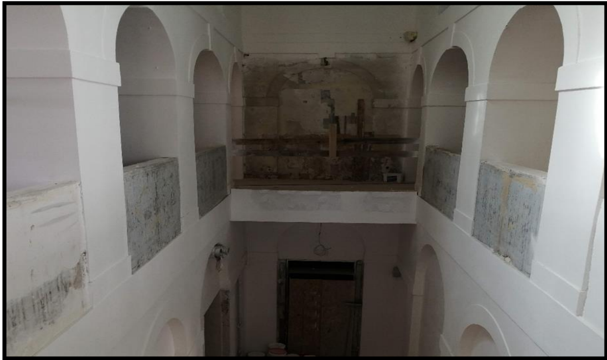
Slika 17 Predvorje na trećem katu s galerijama
