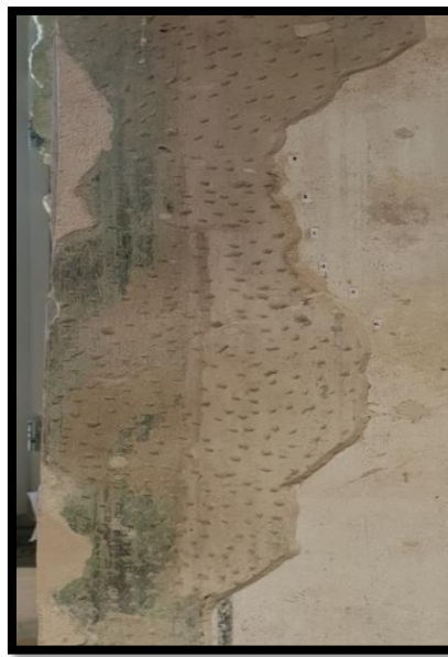
Slika 85 Prostorija 208, sjeverni zid, detalj ispiketane mramorizacije
