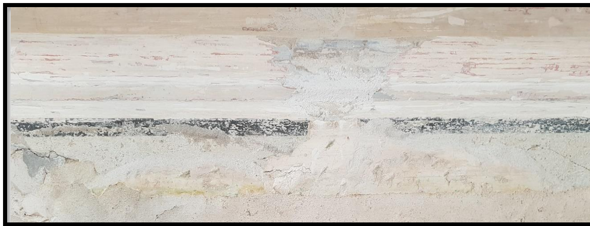
Slika 63 Pohabanost slikanog sloja profiliranog vijenca
