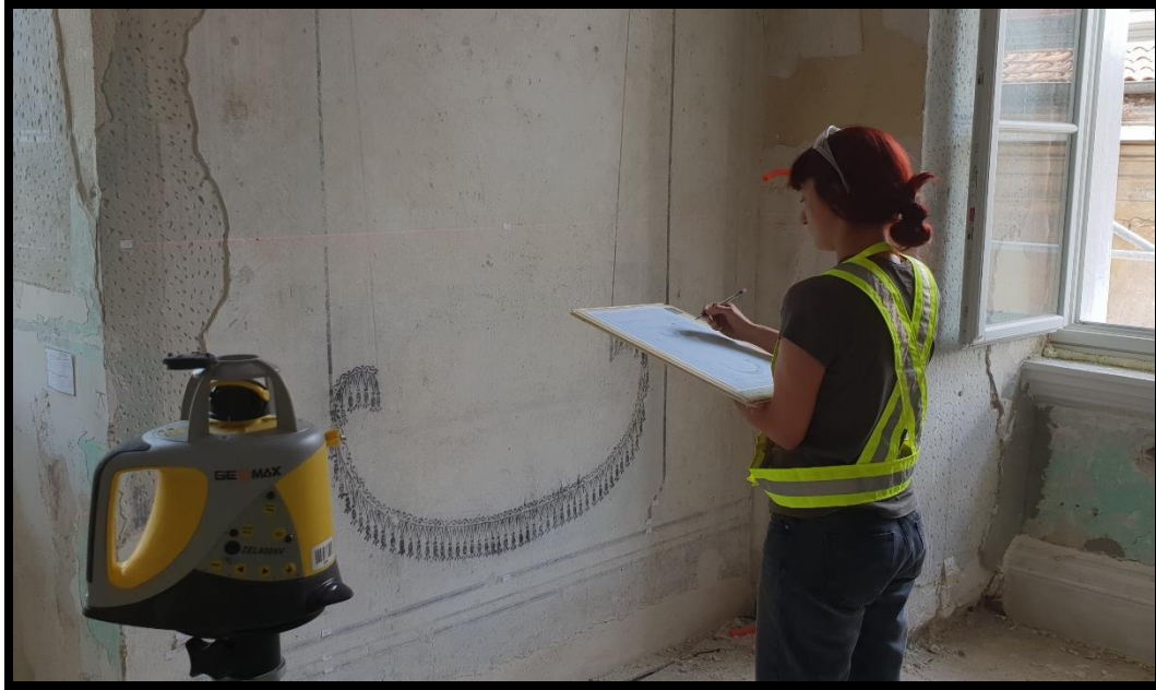
Slika 64 Drugi kat, prostorija 208, sjeverni zid, izrada grafičke dokumentacije in-situ
