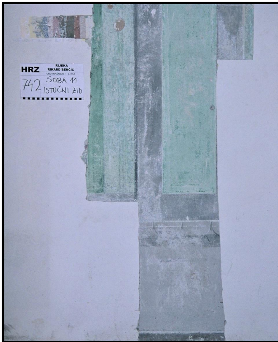
Slika 33 Treći kat, prostorija 311, sonda s otkrivenim detaljem mramoriziranog parapeta
