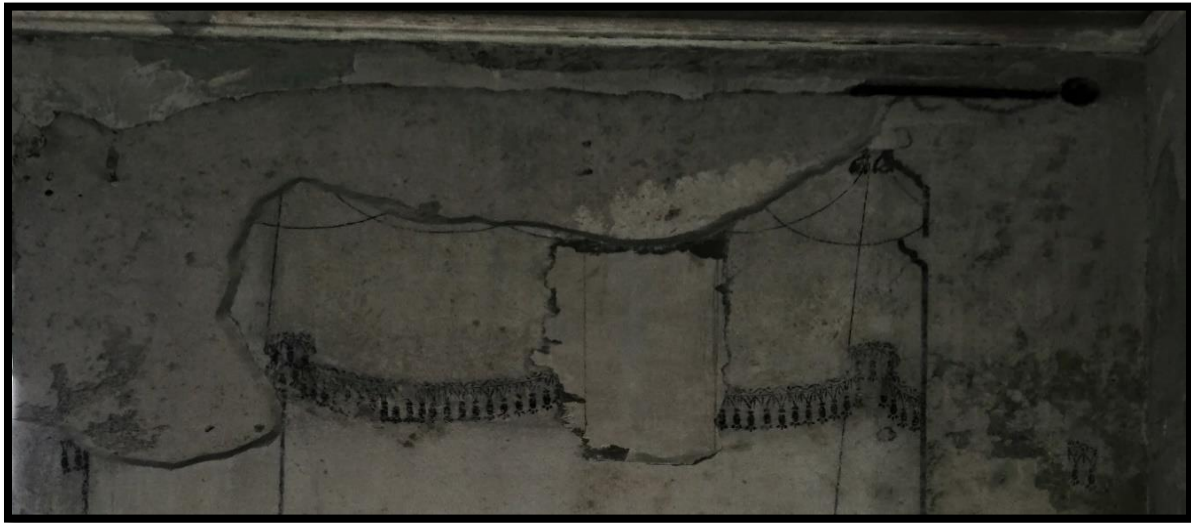
Slika 57 Drugi kat, prostorija 208, sjeverni zid, velike lakune u gornjoj zoni, stanje prije početka radova
