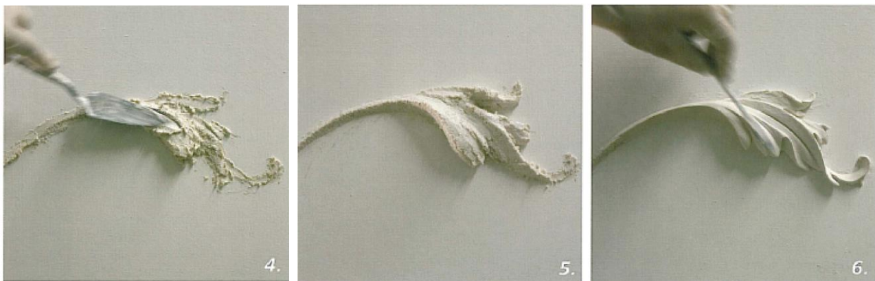
Sl. 131 - Faze in situ modeliranja štuka
