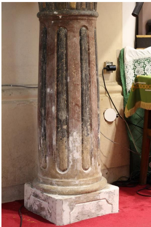
Sl. 115 – Baza stupa nakon izvedenih nadoknada u sloju nosioca
