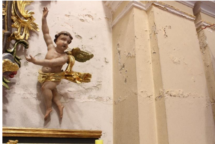
Sl. 84 - Vlaga na sjevernom zidu uz oltar sv. Vida
