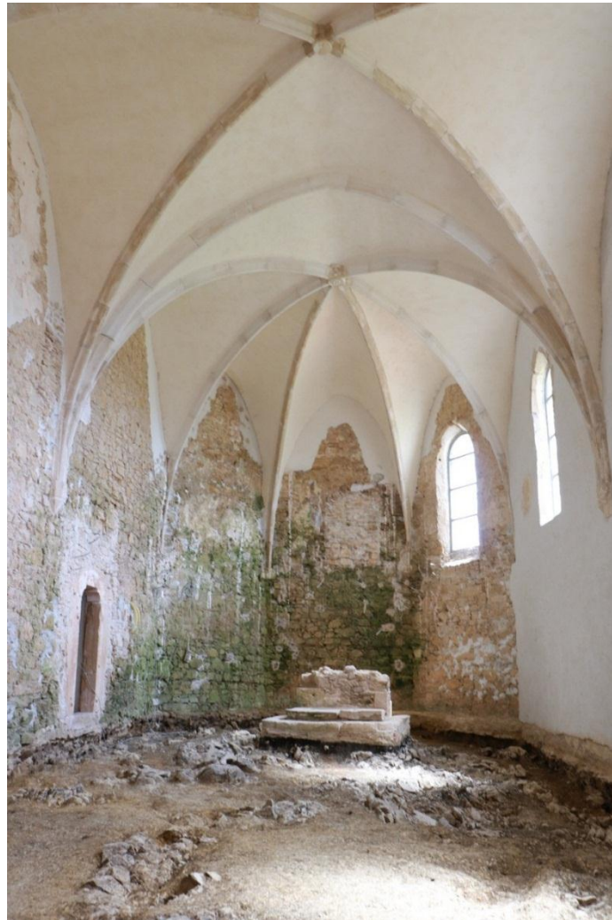
Slika 6: Pogled na svetište s rekonstruiranim gotičkim svodom s rebrima, stanje iz 2018. godine
