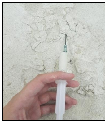
Slika 44. Konsolidacija nestabilnih dijelova
