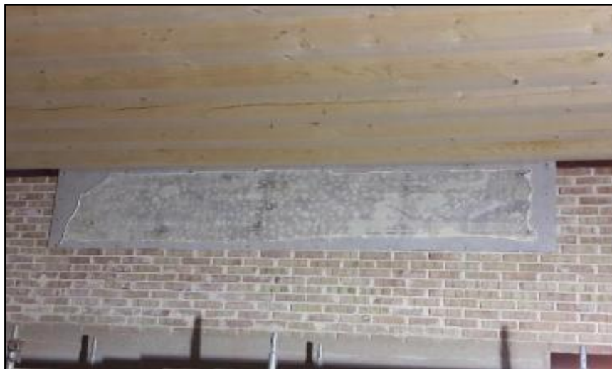
Slika 104. Total zidnog oslika na aluminijskoj ploči nakon fiksiranja na zid
