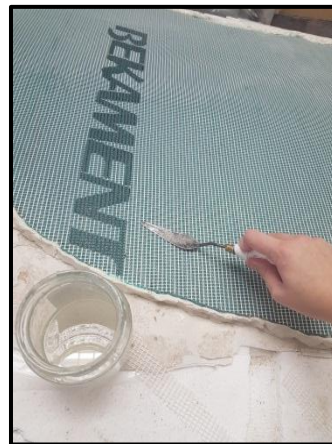
Slika 60. Detalj prilikom nanošenja epoksidne smole
