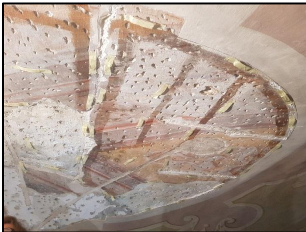
Slika 88 Prikaz detalja svodu gdje se vide odstojnici i mjesta gdje je nanesen primer
