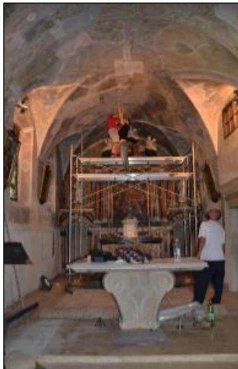
Slika 27. Pripremni radovi prije odvajanja medaljona
