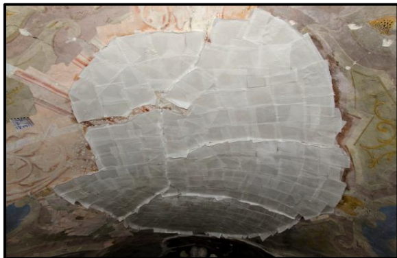
Slika 28. Facing na površini lica slike
