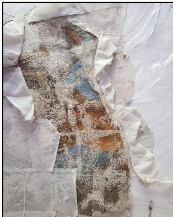
Slika 63. Detalj tijekom uklanjanja facinga
