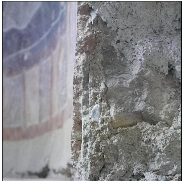
Slika 103. Stratigrafija zidne slike u apside
