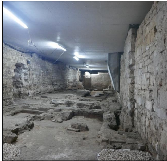
Slika 22. Katedrala u Dubrovniku, prikaz betonske ploče na stupovima u podzemlju današnje katedrale
