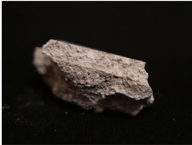
Slika 81. Bijela sitnozrnata žbuka na ulomku s tamno sivom žbukom, bočni presjek
