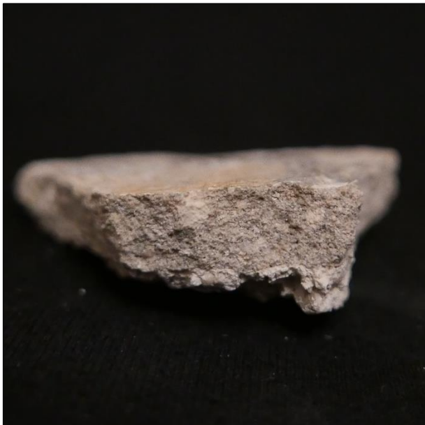
Slika 52. Ulomak s tamnosivom žbukom, bočni presjek
