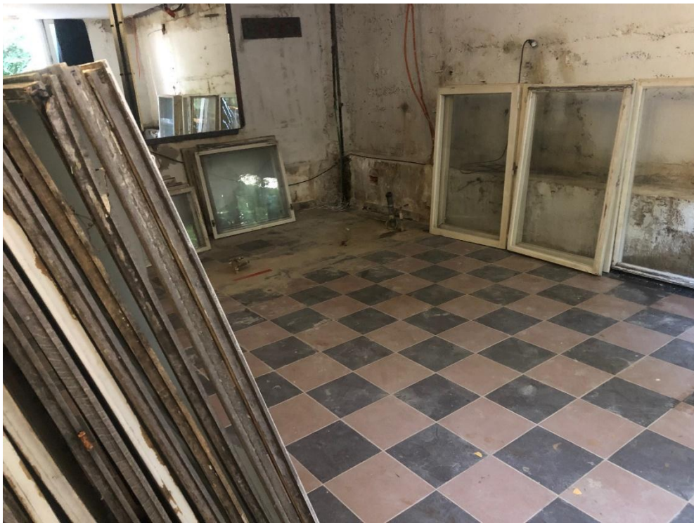
Slika 40 Postavljenje prostorne instalacije
