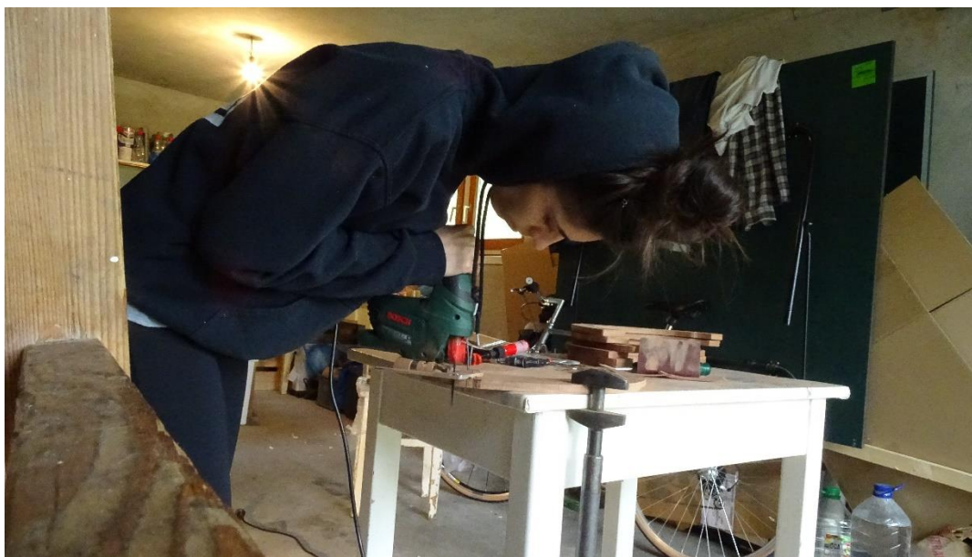
Slika 39: radovi u tijeku, piljenje letvica u polukružni oblik izvornih elemenata, fotografirala Sonja Pavin, Zagreb, 2020.
