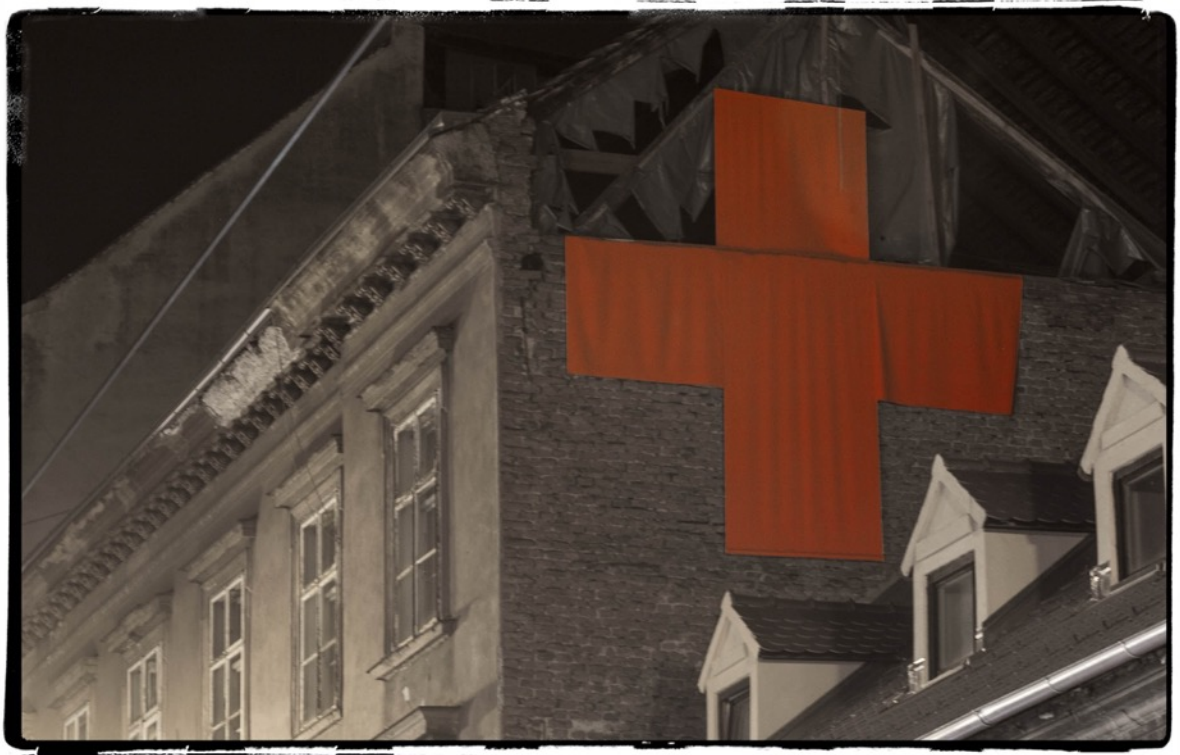
slika 29. Crveni križevi na zgradama oštećenima u potresu, Ilica 88, Zagreb, 2020. (foto Jasmin Krpan)
