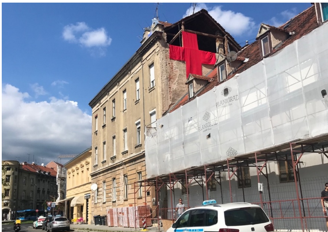
slika 20. Crveni križevi na oštećenim zgradama u potresu, Britanski trg 12, Zagreb, 2020.
