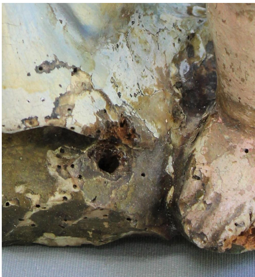
Slika 33. Detalj, postolje, prednja strana, zatečeno stanje, rupa od čavla, dokumentirala: E. Baričević 2022.
