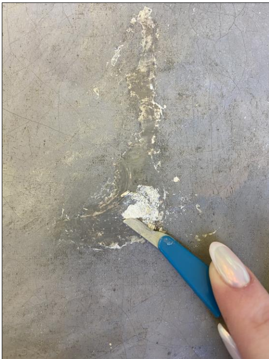
Slika 68. Uklanjanje kita mehaničkim putem, uporabom skalpela, snimila Iva Galijan, 2023.
