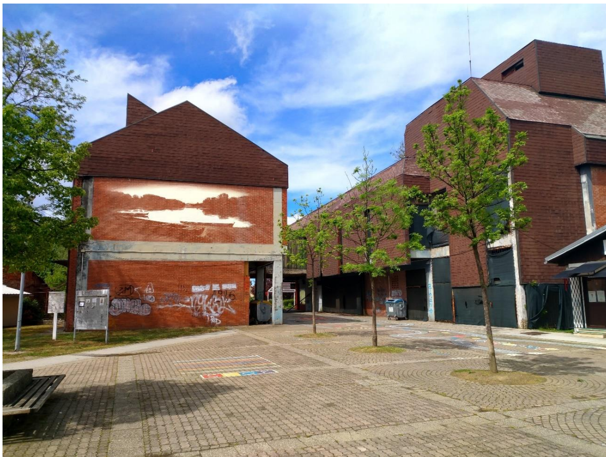
Slika 79 Prikaz murala s rijekom Kupom i starim mostom na ruševini robne kuće
