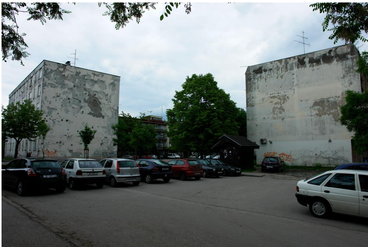
Slika 35 Pogled na Trg narodnih učitelja s oštećenim zgradama (foto: Davor Žilić)
