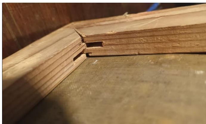
Slika 28. Podokvir je sastavljen od četiri letvice koje su spojene utorom i perom (fotografirao Antun Škrlec, 1.9.2022.)
