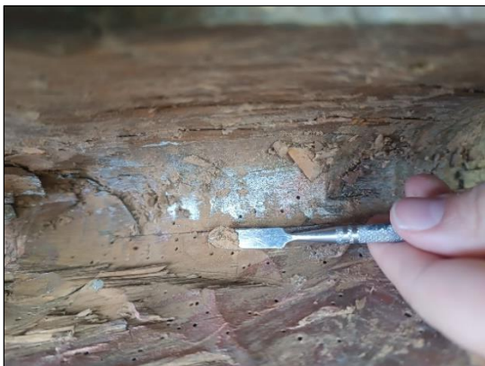
Slika 121. Proces nadoknade oštećenja u sloju drvenog nosioca Grilith Holzkit kombinacijom nijanse fichte i nussbaum , fotografirala: S.Knežević, svibanj 2024.
