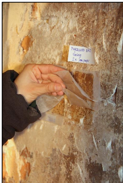
Slika 82. Proba veziva za facing
