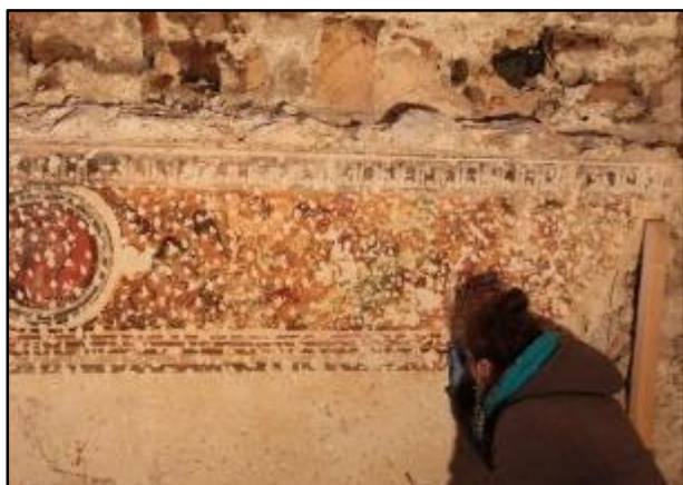
Slika 49. Prvi kat, središnja dvorana, zapadni zid, detalj oslika iz 16. stoljeća
