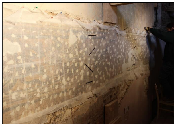
Slika 86. Postavljanje dvaju slojeva japan-papira + pamučne gaze i označeni spojevi reza plavim trakicama
