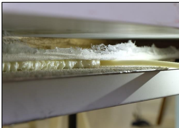
Slika 133. Dodatno injektiranje PUR pjene
