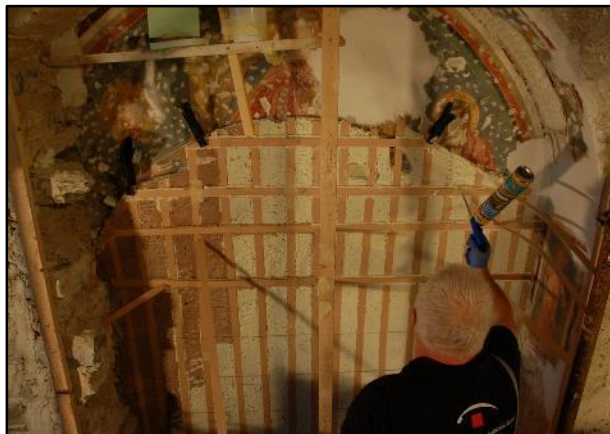
Slika 5. Rado Zoubek primjenjuje metodu s letvicama
