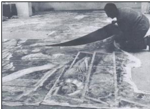
Slika 29. Leonetto Tintori, Camposanto, Pisa, prikaz rada Leonetta Tintoria, odvajanje zidnih slika nakon poplave
