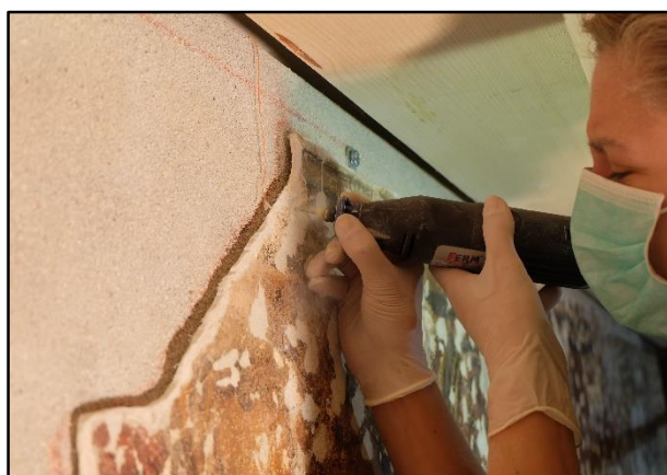
Slika 149. Obrada rubova električnom brusilicom
