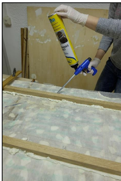
Slika 121. Lijepljenje hrastovih letvica na lice zidnog oslika pomoću PUR pjene
