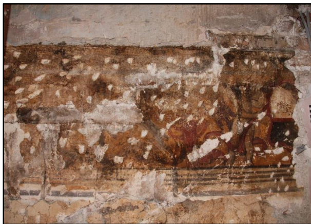
Slika 76. Detalj, zidni oslik s tragovima drvenog dvokrakog stubišta koje je bilo prislonjeno i pričvršćeno dijagonalno na zid
