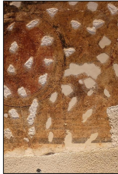
Slika 155. Detalj, utisnuta nadomjesna žbuka do razine izvornog intonaca
