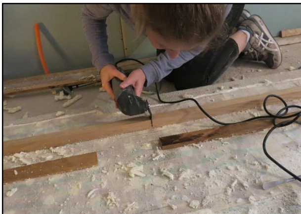
Slika 137. Skidanje pomoćnih letvica s lica oslika
