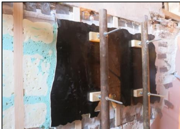
Slika 89. Čvrsti nosilac na licu slike sastoji se od drvenih letvica vezanih PUR pjenom i panel ploče koja je izrezana tako da prati oblik fragmenta i cijela se konstrukcija učvrstila za skelu vijcima
