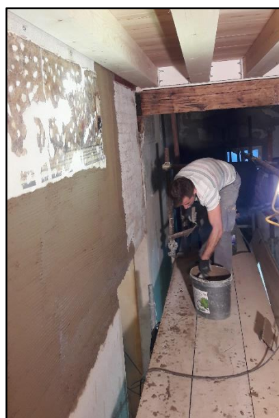
Slika 159. Nanošenje dugog sloja žbuke oko fragmenta
