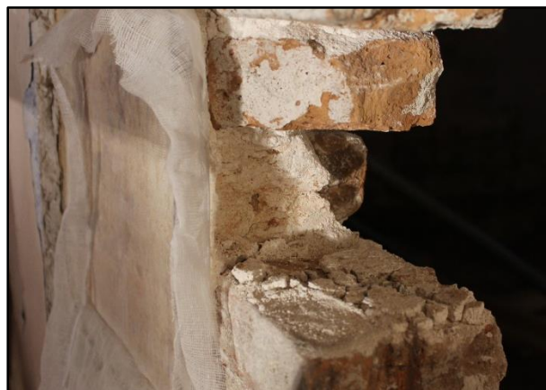
Slika 84. Proba odvajanja opeke s poledine zida
