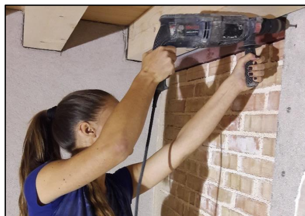
Slika 140. Bušenje rupa u čeličnoj gredi i opeci
