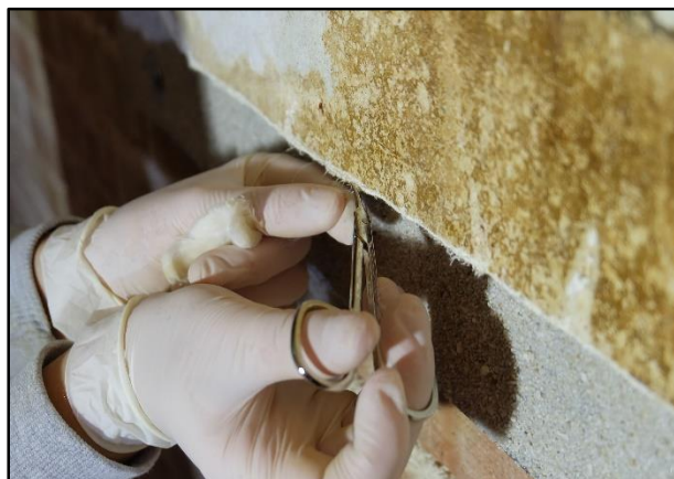
Slika 148. Uklanjanje viška gaze i vapnenog kazeinata s rubova
