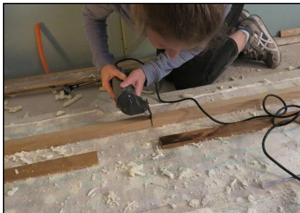
Slika 137. Skidanje pomoćnih letvica s lica oslika
