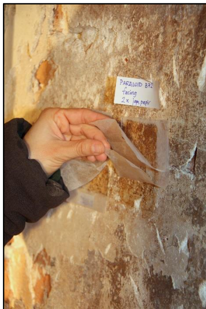
Slika 82. Proba veziva za facing
