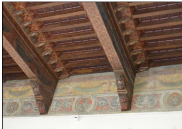
Slika 61. Sala del Pappagallo, Palazzo Venezia, Rim, 15. stoljeće, drveni strop ukrašen ukrasnim motivima koji podupiru grede s dvostrukim policama
