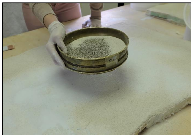
Slika 107. Posipavanje vapnenog drobljenca na sloj vapnenog kazeinata
