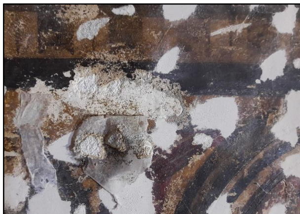
Slika 145. Oštećenje slikanog sloja tijekom skidanja facinga
