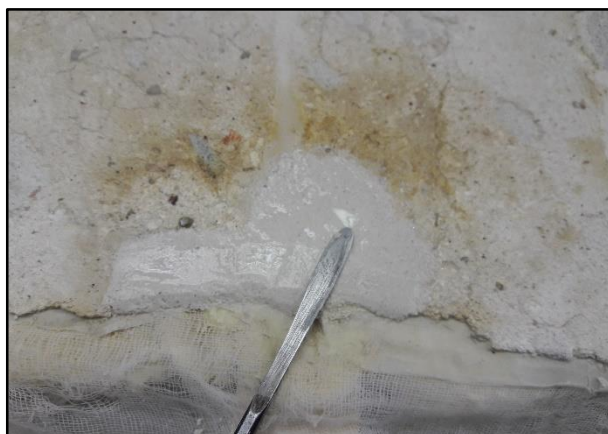
Slika 103. Popunjavanje oštećenja vapnenom žbukom u omjeru 1 : 4
