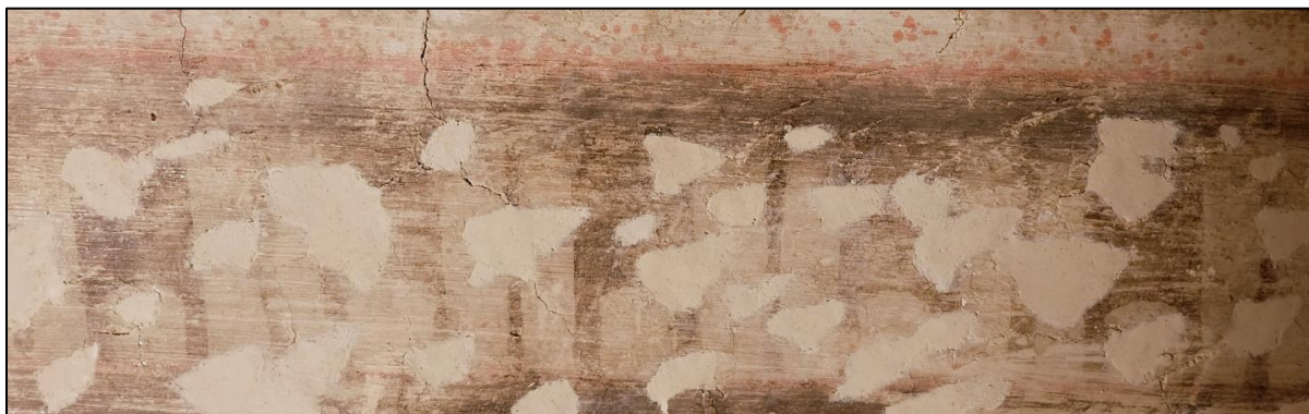
Slika 105. Detalj crvene linije dobivene ispucavanjem konopca na sveži intonaco . Vidljiv je trag prskanja boje u koju je konopac bio umočen.
