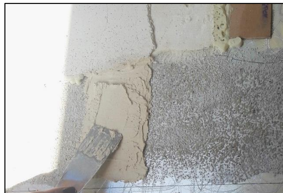
Slika 160. Nanošenje vapnene žbuke na sloj vapnenačkog drobljenca zalijepljenog epoksidnim ljepilom.
