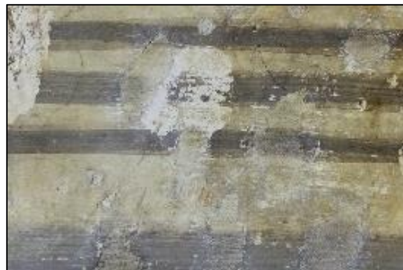
Slika 188. Testno područje u donjem desnom uglu fragmenta. Na žbukanim nadoknadama toniranim lokalnim tonom napravljena je rekonstrukcija crnih horizontalnih linija (tona nešto svjetlijeg od izvornika).
