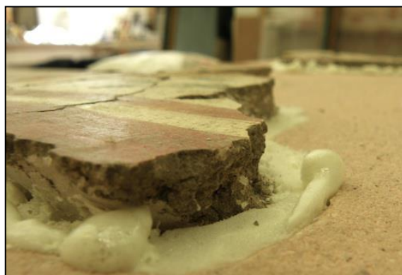
Slika 33. Prikaz ispune prostora između fragmenta i prvog sloja prezentacijske žbuke poliuretanskom pjenom.
