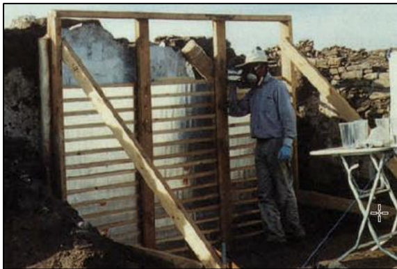
Slika 42. Drveni okvir privremenog nosača ojačan drvenim letvicama, zapečaćen i djelomično ispunjen poliuretanskom pjеноm.
