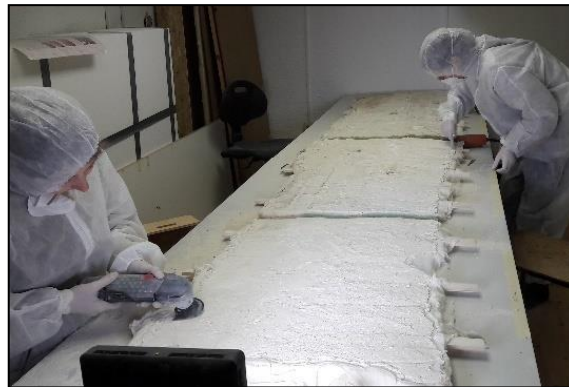
Slika 132. Stanjivanje i izravnavanje žbuke sljubnica i intonaca električnim brusilicama pod kosim svjetlom.
