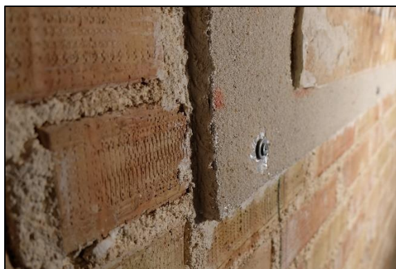
Slika 189. Spoj pokretnog i nepokretnog nosača ispunjen industrijskom žbukom Renoplus .
