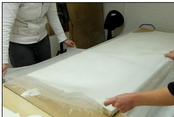
Slika 144. Polaganje napete gaze na svježi nanos vapnenog kazeinata.
