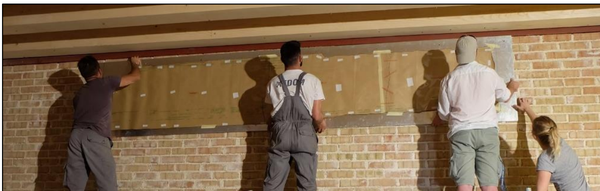
Slika 158. Probno postavljanje pokretnog nosača na novosagrađeni zid (južni dio zapadnog zida).
