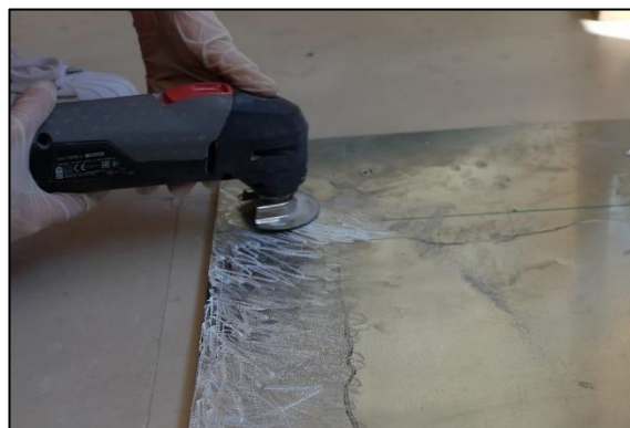
Slika 162. Hrapavljenje površine aluminijske ploče.
