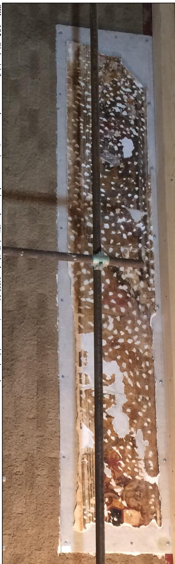
Slika 192. Cjeloviti fragment nakon nanošenja prvog sloja grube ("špric") žbuke NHL Vorspritzer na zid od opeke.
