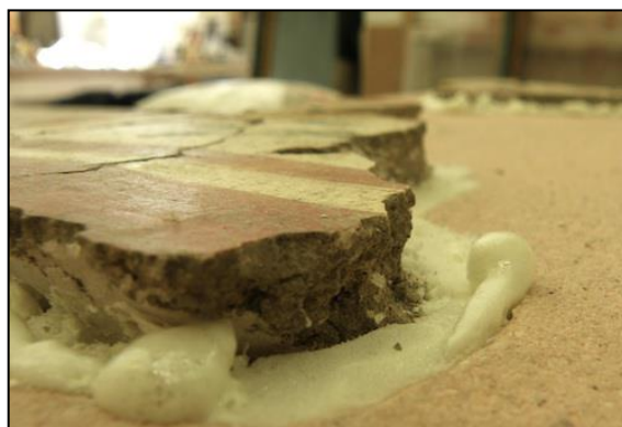
Slika 33. Prikaz ispune prostora između fragmenta i prvog sloja prezentacijske žbuke poliuretanskom pjenu.
