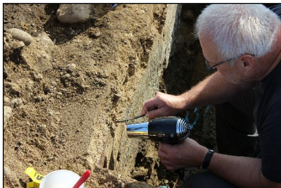
Slika 55. Uklanjanje sipke žbuke oko rubova fragmenata.
