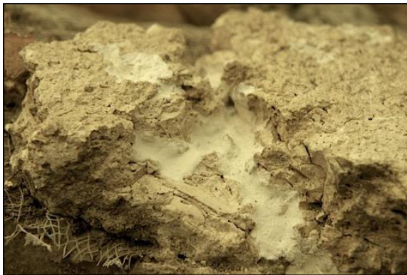
Slika 26. Manje pukotine u žbuci poledine zapunjene su smjesom materijala VAPO 0/1 i vode.
