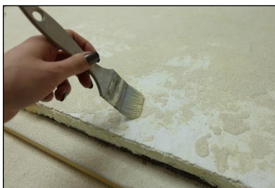
Slika 141. Otprašivanje nevezanih zrnca agregata nakon sušenja prvog sloja vapnenog kazeinata.
