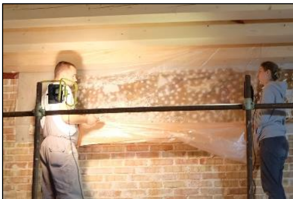
Slika 191. Zaštita fragmenta zidne slike prije nanošenja grube žbuke („špric“ žbuka) prekrivanjem zaštitnom folijom.
