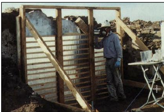
Slika 42. Drveni okvir privremenog nosača ojačan drvenim letvicama, zapečaćen i djelomično ispunjen poliuretanskom pjenom.
