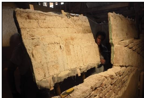
Slika 128. Središnji dio fragmenta nakošen prije odvajanja od skele.
