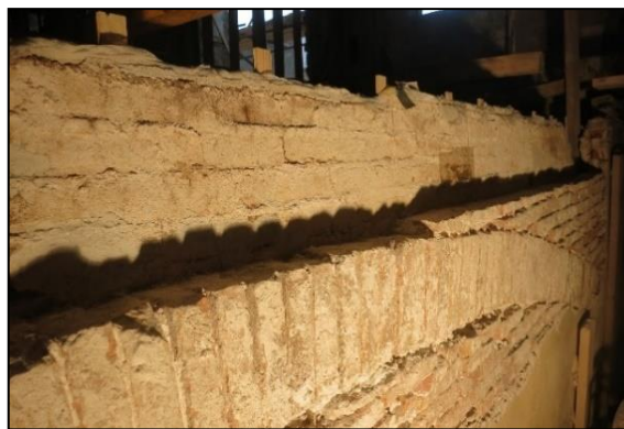
Slika 100. Nosač fragmenta zidne slike, zid od opeke. Na slici se vidi luči oblik slaganja opeka u gornjoj zoni zida.
