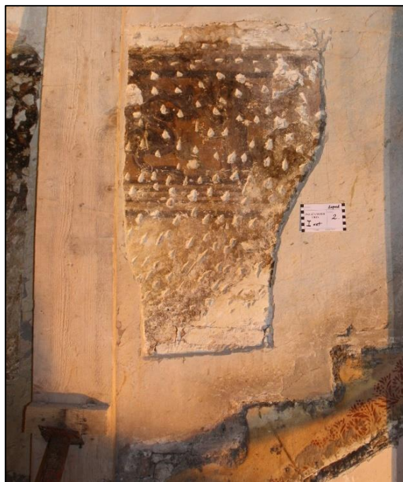
Slika 69. Detalj oslika vijenca u središnjem salonu prvog kata kuće Moise, otkriven ispod naknadnih slojeva žbuka i naliča na južnom dijelu zapadnog zida. U donjem dijelu fotografije vidljivi su tragovi položaja nekadašnjeg stubišta iz 19. stoljeća.
