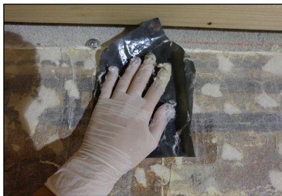
Slika 176. Pamučna vata natopljena acetonom i prekrivena polietilenskom folijom, kako bi se usporilo isparavanje otapala.
