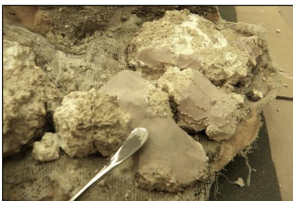
Slika 27. Veća oštećenja u žbuci zapunjena su laganom nadoknadnom žbukom koju čine VAPO 0/1 i punilo od recikliranog stakla.
