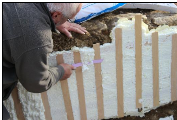
Slika 60. Rezanje poliuretanske pjene nanese između vertikalnih drvenih letvica kako bi se dovela u razinu s njima.
