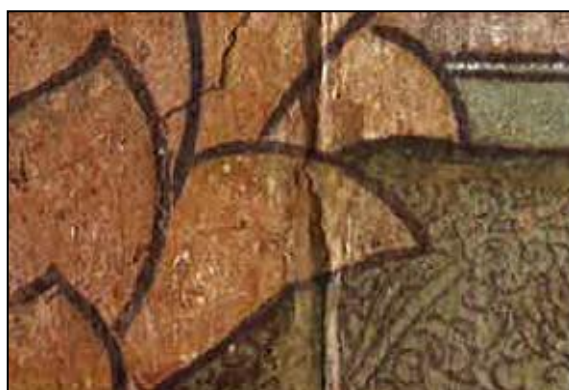
Slika 20. Zatečeno stanje masonit ploča s ispunama iz 1933. i 1983. godine.
