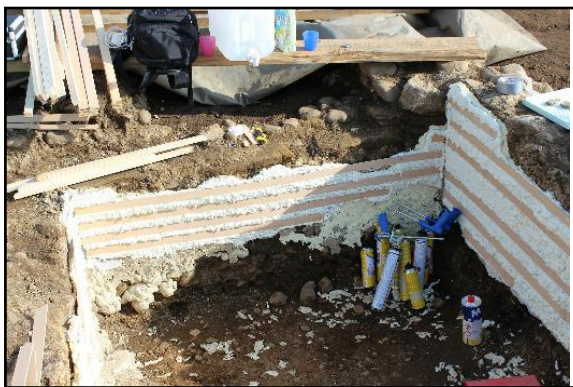
Slika 59. Izgled površine nakon što su postavljene horizontalne drvene letvice te je prostor među njima zapunjen poliuretanskom pjenu.
