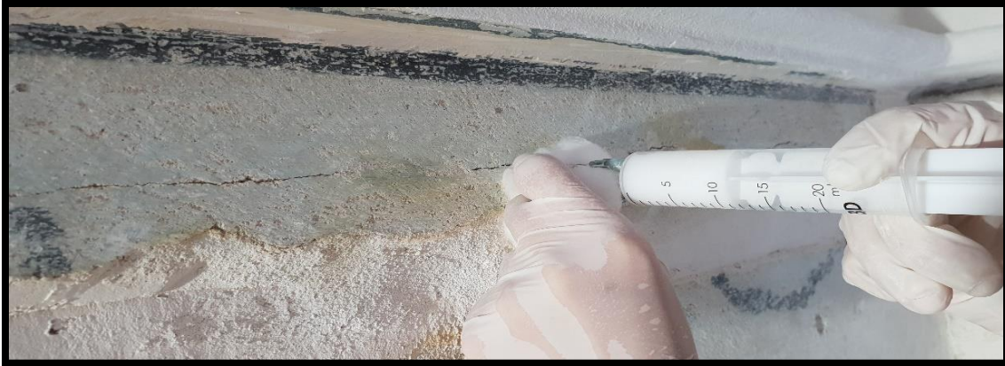
Slika 77 Detalj, injektiranje horizontalnog napuknuća u gornjoj zoni
