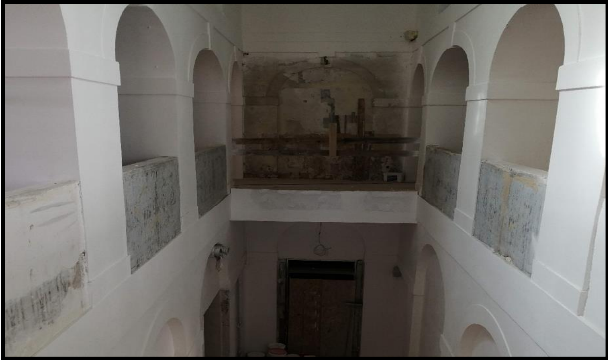
Slika 17 Predvorje na trećem katu s galerijama
