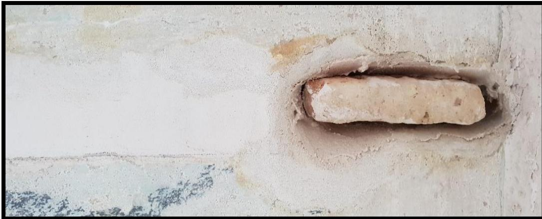
Slika 80 Detalj, umetnuti komad izvorne opeke na mjestu značajnog strukturnog oštećenja nosioca
