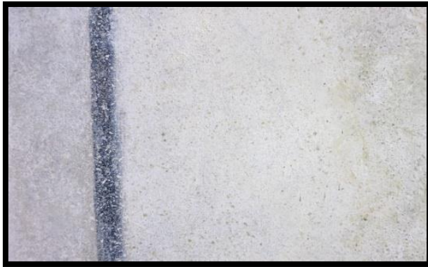
Slika 95 Detalj, isprskani dio, imitacija istrošenosti
