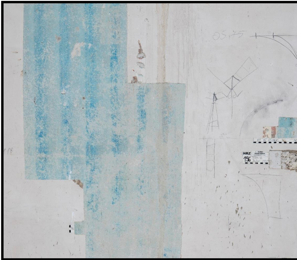
Slika 46 Drugi kat, soba 212, južni zid, detalj sonde s prikazom dekorativnog zastora prije početka radova
