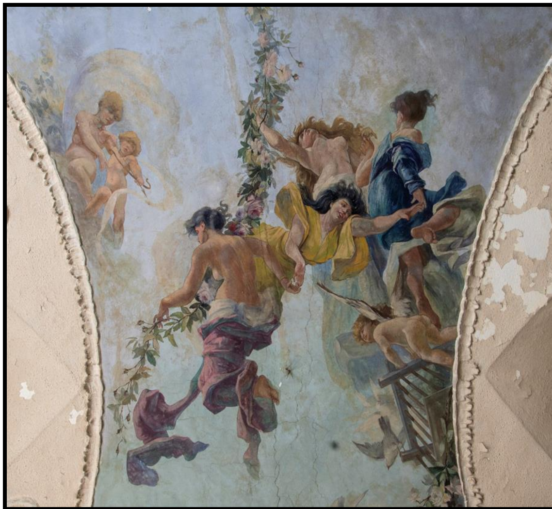
Slika 22 Zidni oslik, prvi kat, svod središnjeg salona, rad Giovannija Fumija, prikaz personificiranih godišnjih doba na stropu, stanje tijekom radova
