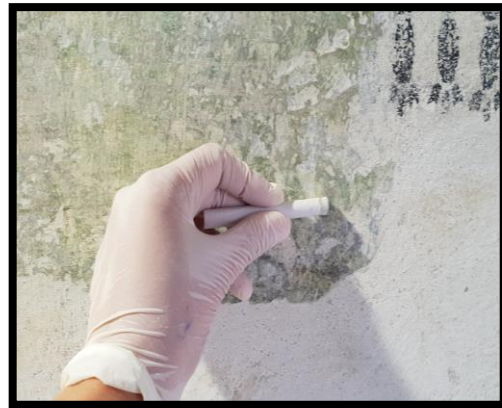
Slika 70 Detalj, čišćenje zidne slike staklenim vlaknima
