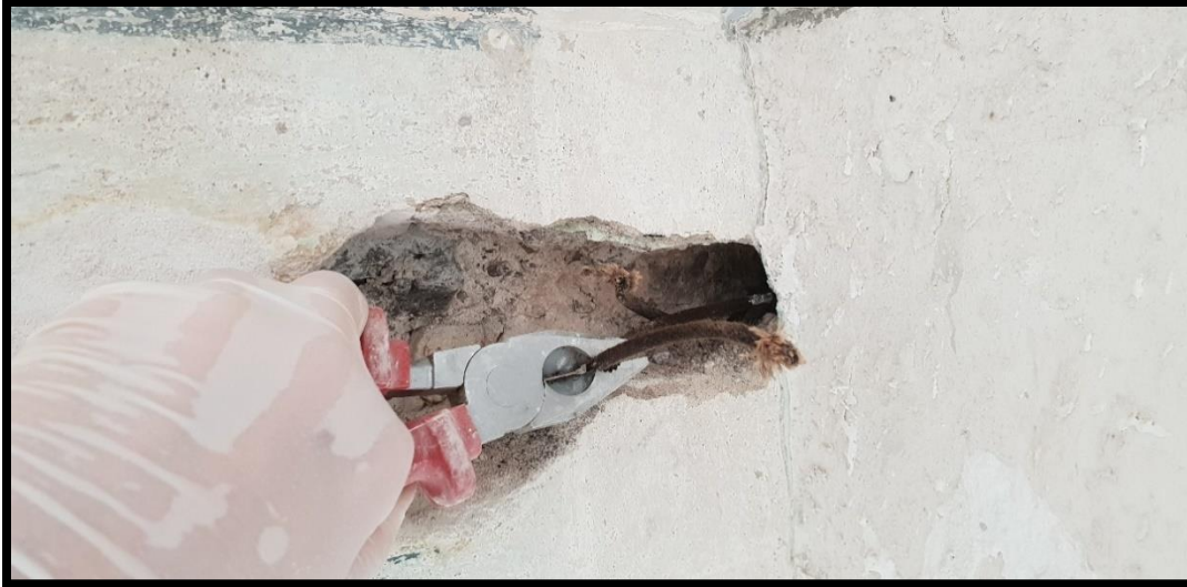
Slika 73 Detalj, uklanjanje žice kliještima
