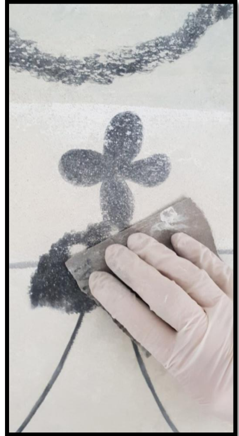
Slika 94 Detalj, uporaba brusnog papira za dobivanje izgleda „starosti“
