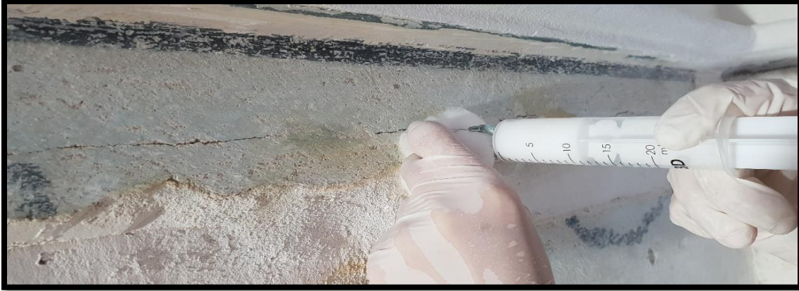
Slika 77 Detalj, injektiranje horizontalnog napuknuća u gornjoj zoni
