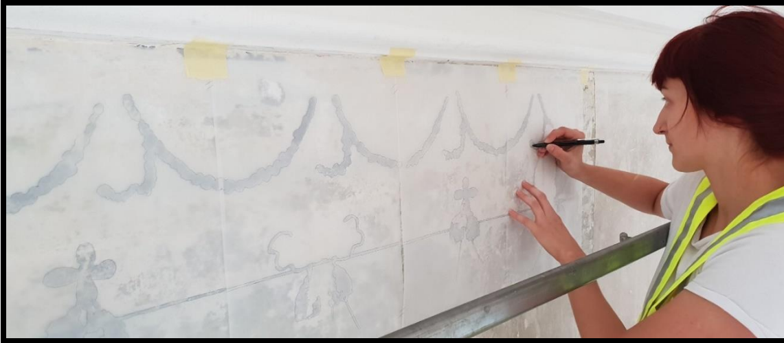
Slika 90 Prostorija 208, istočni zid, izrada šablona za rekonstrukciju slikanog sloja
