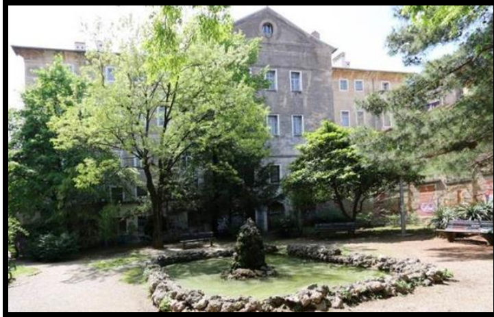
Slika 2 Stražnja strana palače Šećerane prije početka radova
