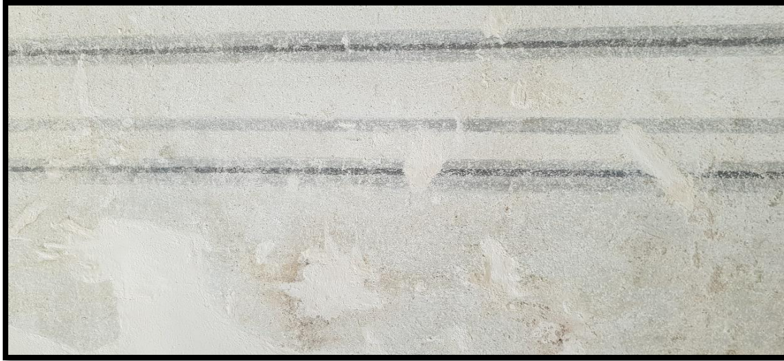
Slika 87 Detalj, žbukane nadoknade u sloju intonaca u zoni parapeta
