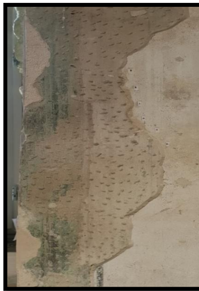
Slika 85 Prostorija 208, sjeverni zid, detalj ispiketane mramorizacije
