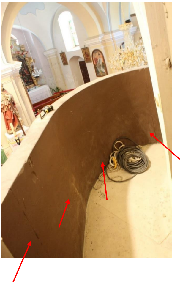
Sl. 39 - Spojevi ograde, pogled iz govornice
