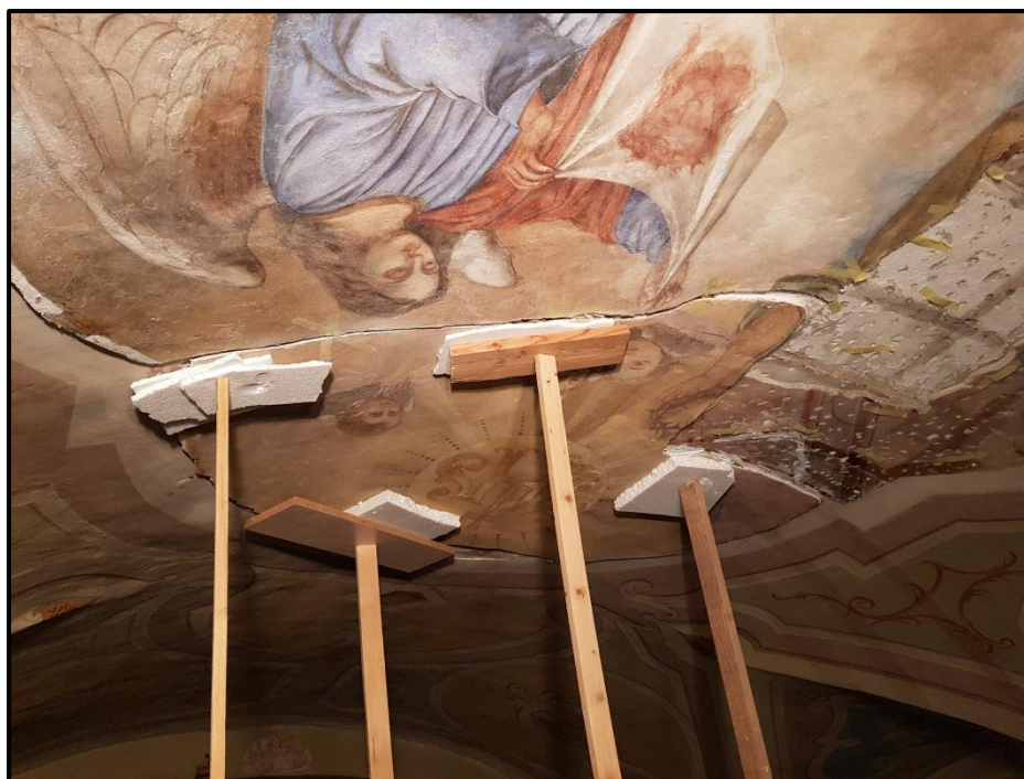
Slika 92. Osiguranje fragmenta pomoću stiropora, dasaka i letvica koje su omogućile ravnomjerni pritisak
