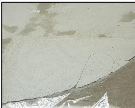
Slika 51. Detalj nakon polaganja prvog sloja reintegracijske žbuke
