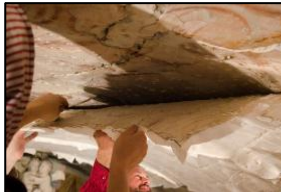
Slika 29. Detalj odvajanja zidne slike stacco metodom
