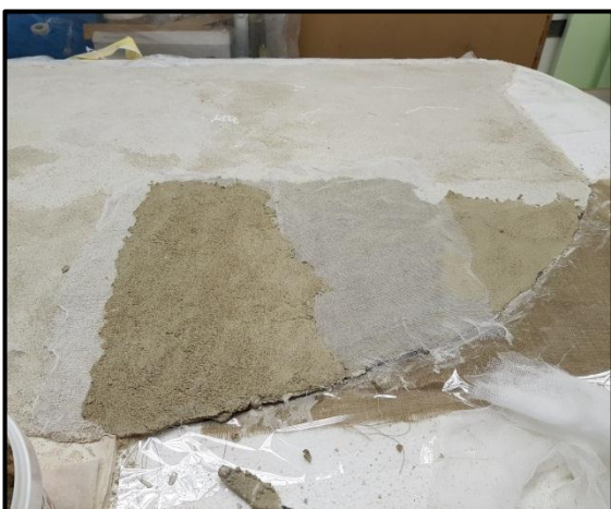
Slika 52. Nanos drugog sloja reintegracijske žbuke na sloj gaze
