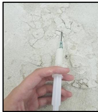
Slika 44. Konsolidacija nestabilnih dijelova
