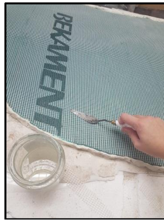
Slika 60. Detalj prilikom nanošenja epoksidne smole
