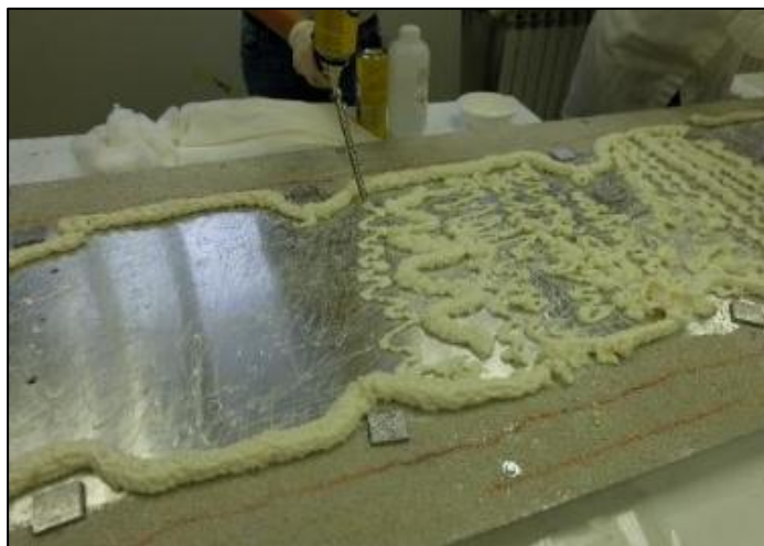
Slika 103. Postavljanje PUR pjene
