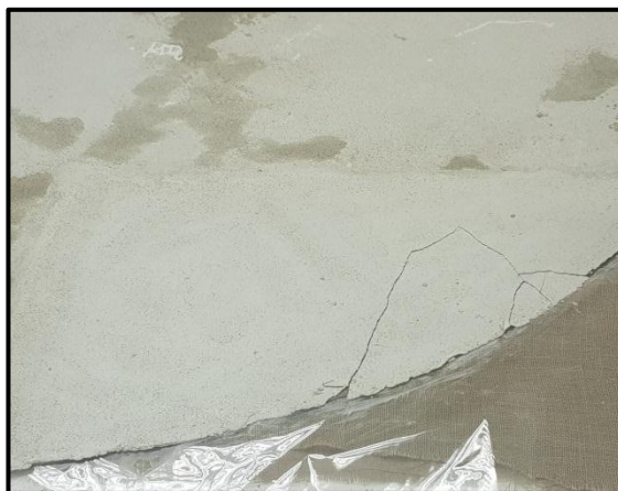
Slika 51. Detalj nakon polaganja prvog sloja reintegracijske žbuke
