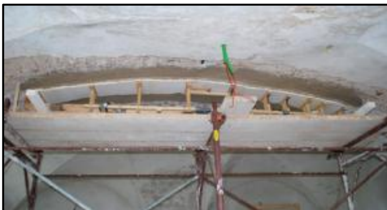
Slika 102. Fragment s pripadajućim potpornjem tijekom vraćanja in situ
