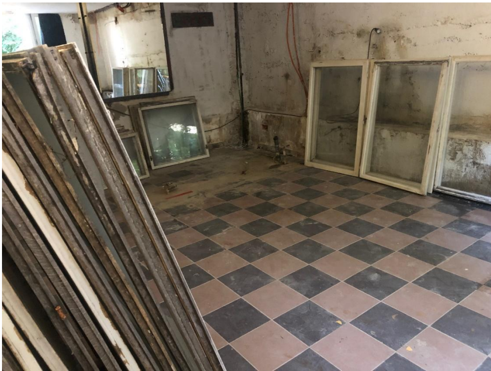
Slika 40 Postavljenje prostorne instalacije
