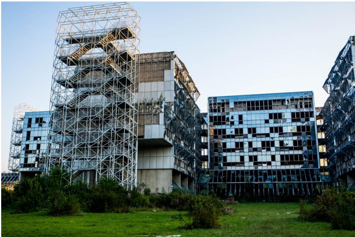
Slika 29 Sjeverna strana kompleksa
