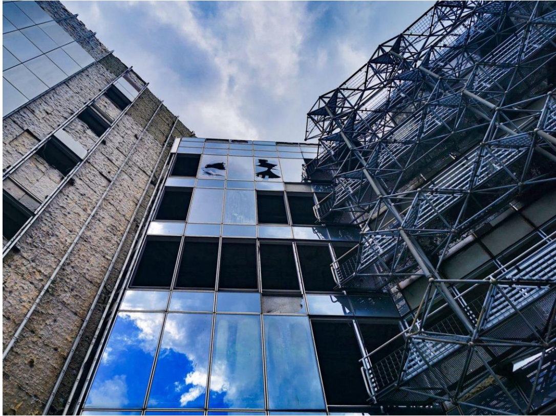
Slika 30 Fasada jednog od planiranih stacionara sa sjeverne strane
