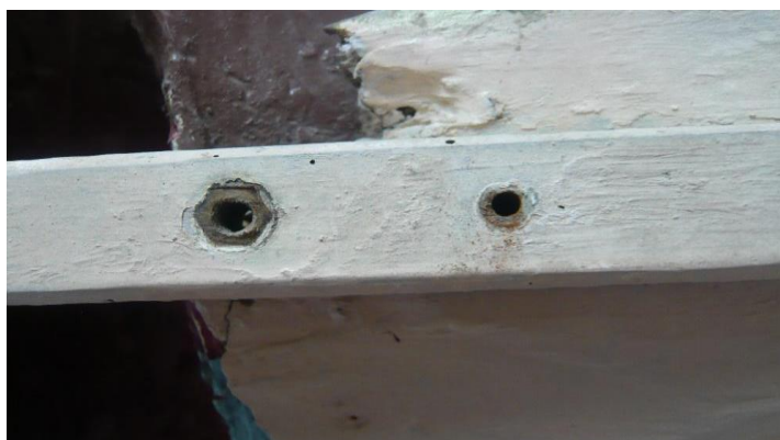
Slika 128. Drvena armatura nakon uklanjanja vijaka, pozadina lijevog krila, u tijeku radova, detalj, fotografirala Hana Knežević 2019.
