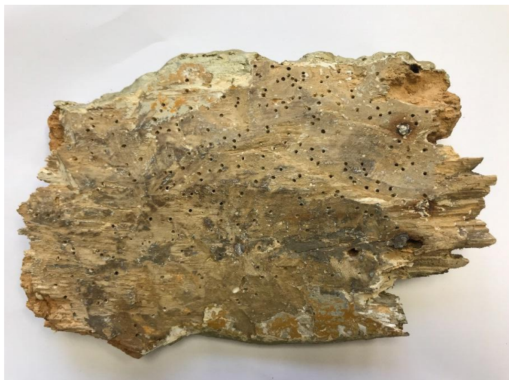
Slika 124. Popunjavanje oštećenja nastalih djelovanjem crvotočine, poleđina lijevog krila, u tijeku radova, detalj fotografirala Hana Knežević, 2019.
