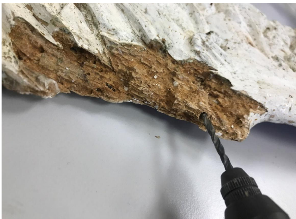
Slika 136. Bušenje rupa za armaturu od drvenih tipli, desno krilo, u tijeku radova, detalj, fotografirala Sara Šipek, 2019.
