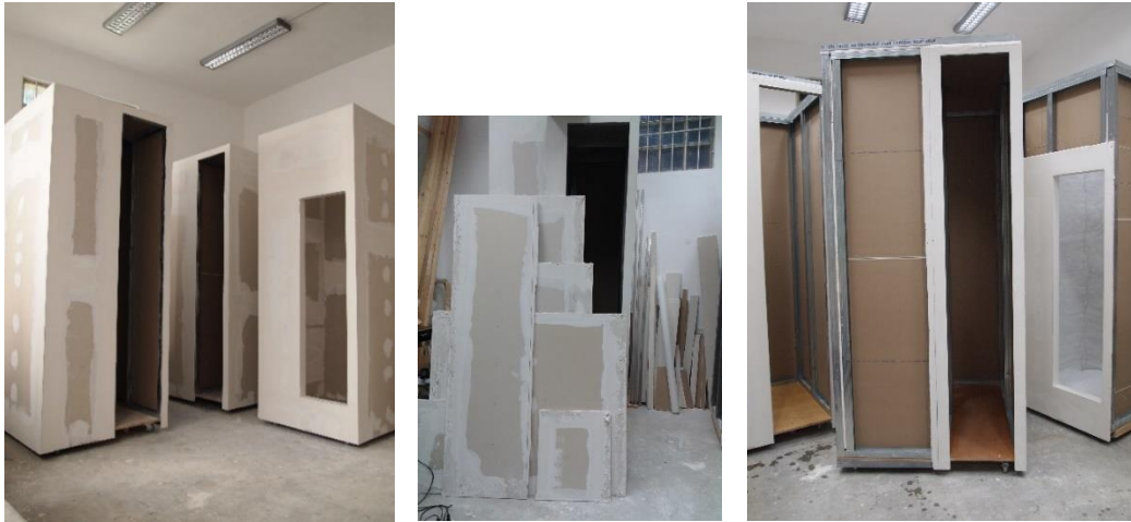
Slika 69. Preslagivanje obloge box -ova
