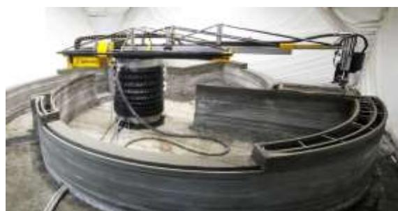
Slika 62: Proces izrade kuće izrađene 3D pisačem
