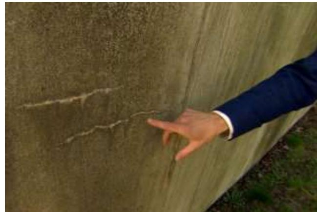
Slika 52: Primjer zacjeljivanja betona
