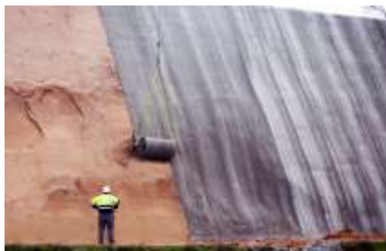
Slika 53: Primjer upotrebe betonske tkanine
