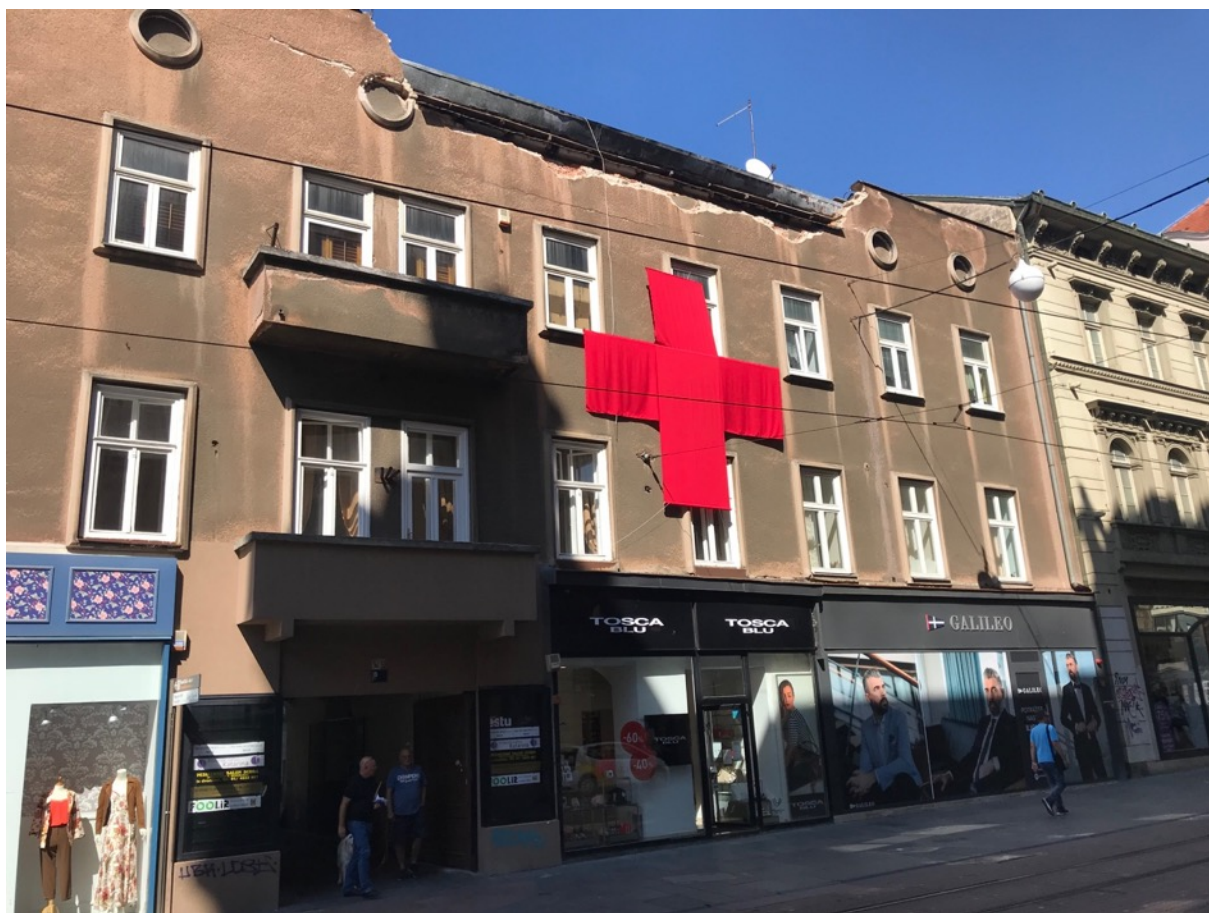
slika 19. Crveni križevi na oštećenim zgradama u potresu, Ilica 8, Zagreb, 2020.
