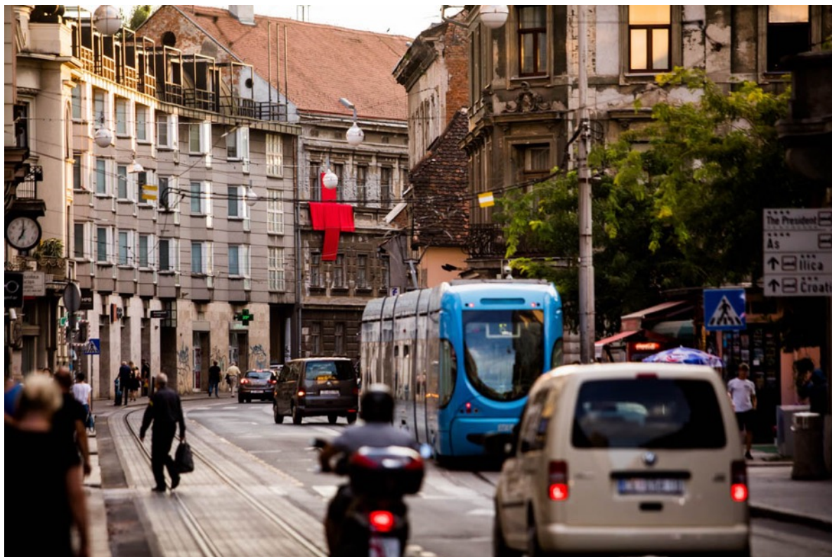
Slika 42. Crveni križevi na oštećenim zgradama u potresu, fotografija iz medija, Lice grada, Zagreb, rujan, 2020.
