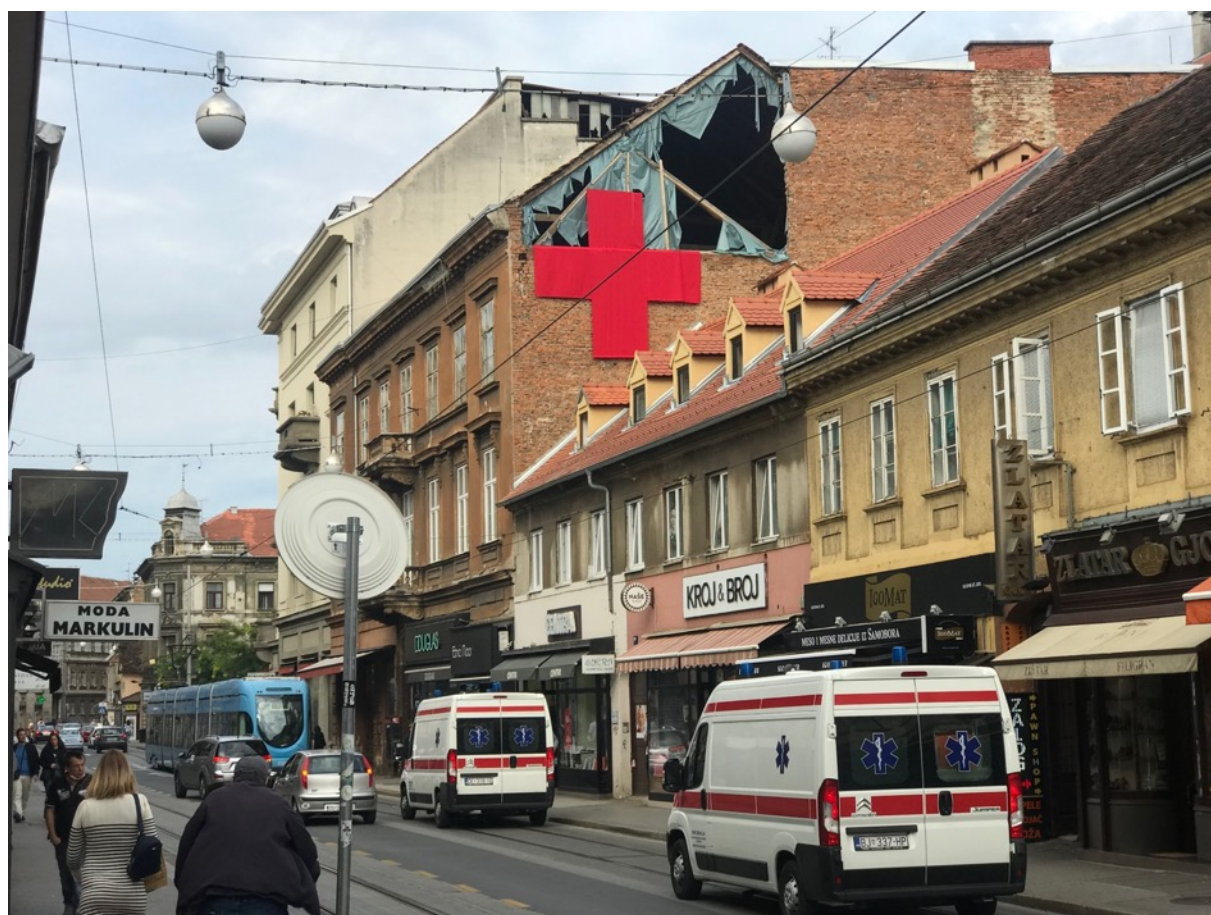
slika 18. Crveni križevi na oštećenim zgradama u potresu, Ilica 88, Zagreb, 2020.
