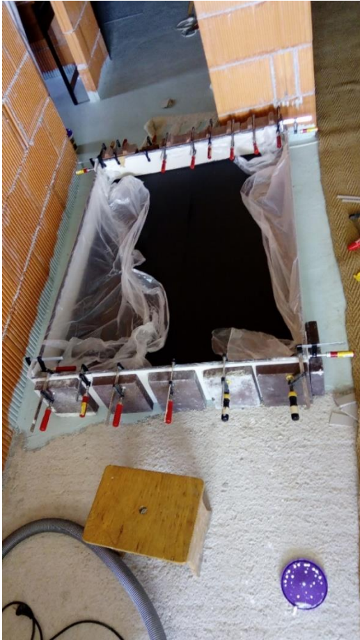
Sl. 21. Ljepljenje okvira od ljepenke
