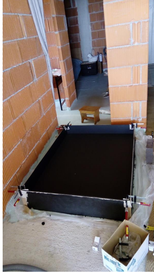
Sl. 22. Ljepljenje uglova okvira
