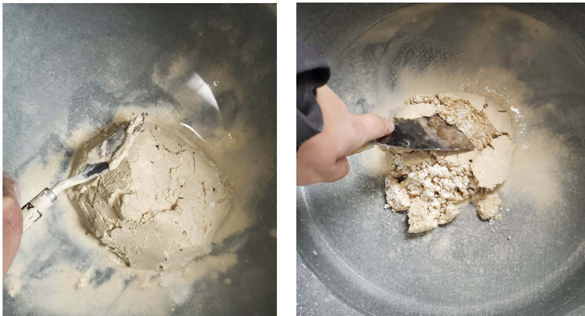
Slike 62 – 63. Pokrivanje raskolina zaglađivanjem vapnenačkog drobljenca pomoću špahtlice (lijevo). Prikaz miješanja žbuke nakon gašenja vapna (desno). Snimio D. Pekić, 2022.
