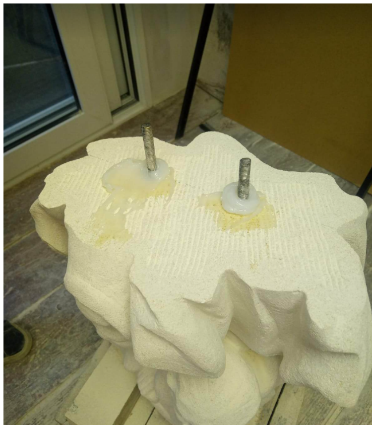
Slika 56. Prikaz apliciranja ankeru netom prije spajanja elemenata. Snimio K. Budiselić, 2022.
